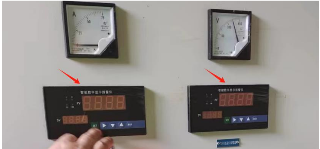
图 4.1.1-3 消防水泵控制柜无高低位水池液位信号
