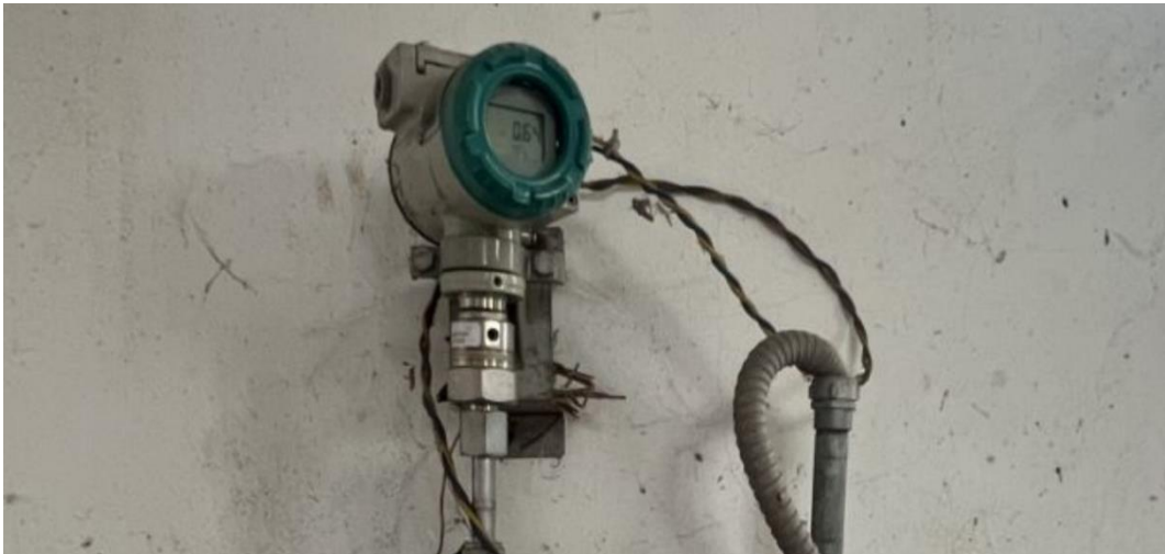
图 4.1.1-1 高位水池液位计现状（由隧道洞口下山管道引入）
