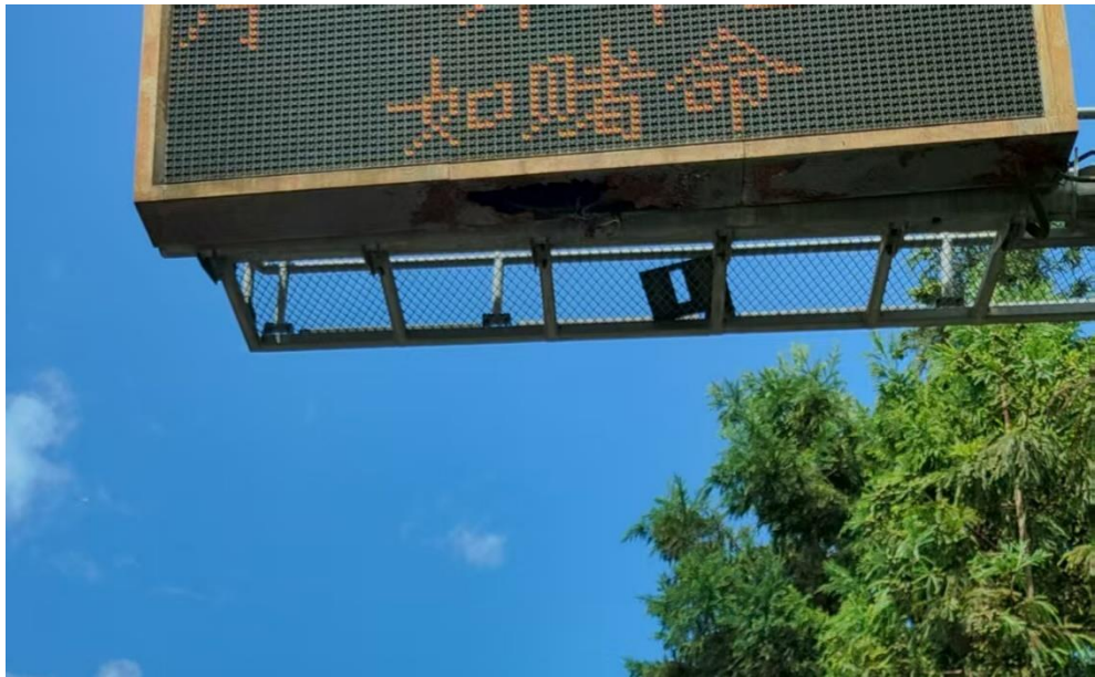
图 4.1-2 情报板的钢结构锈蚀情况严重
