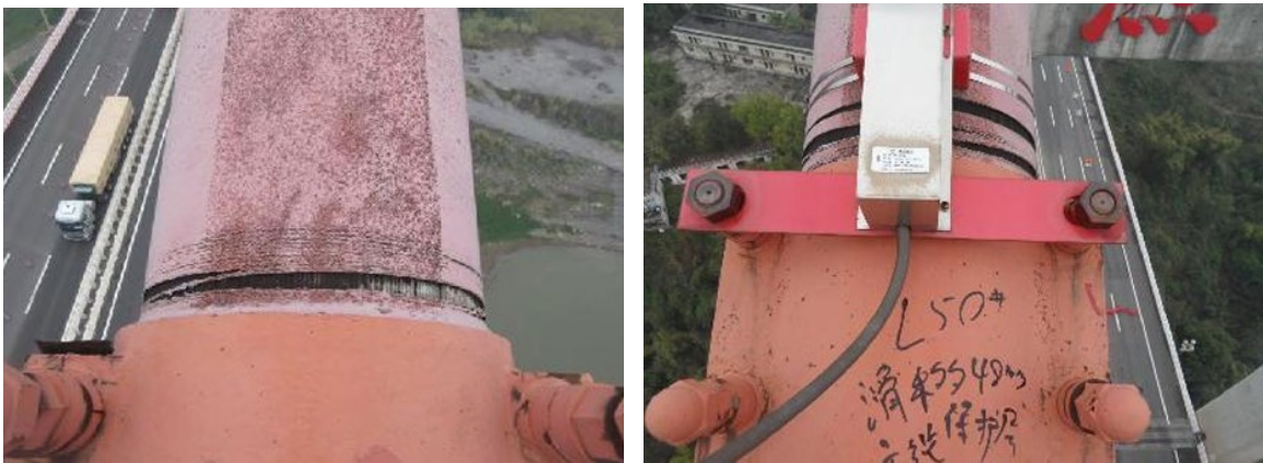
图 1.3-8 索夹滑移及保护层开裂
