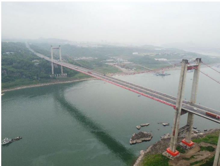
图 1.1-1 鱼嘴两江大桥立面照
