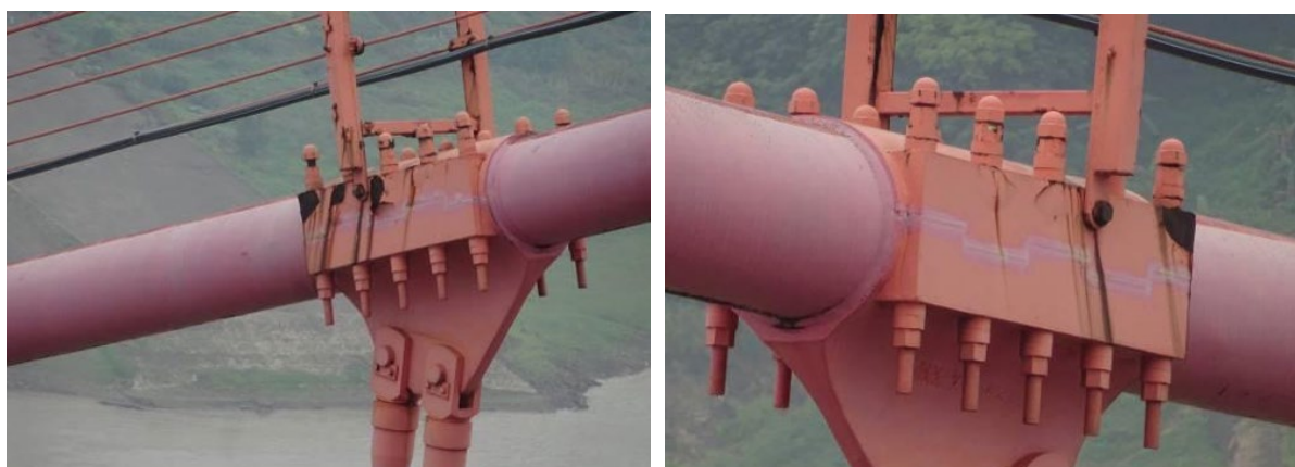
图 1.3-3 索夹涂层脱落
