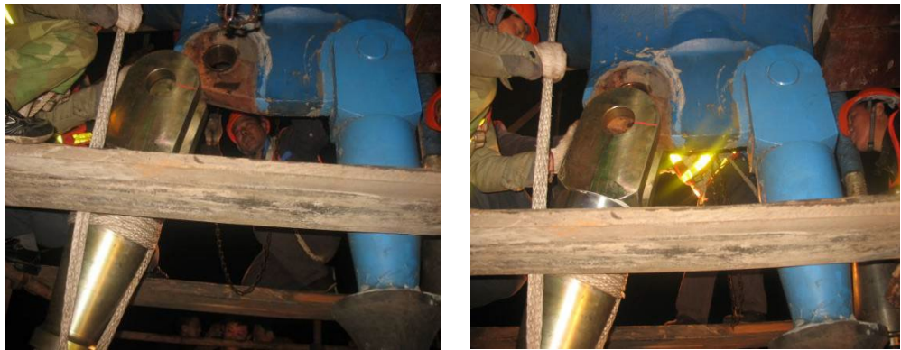
a) 上锚头就位 b) 上锚头安装
