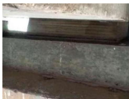
图 5.2-2 R21-21-5#支座老化开裂
