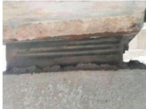
图 5.3-4 R8-7-6# 支座老化开裂
