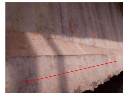
图 5.4-4 L2-3#箱梁纵向裂缝
