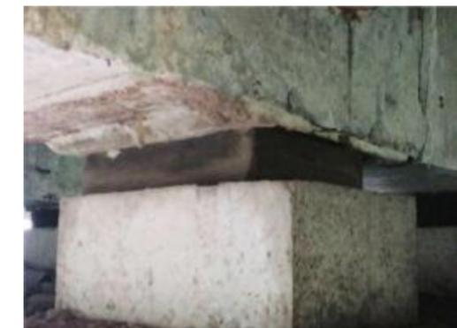
图 5.3-4 R19-19-1~7# 支座板式支座老化变质、开裂
