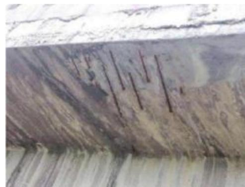
图 5.4-3 L8-1#T 梁破损、露筋
