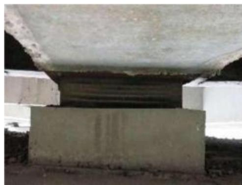
图 5.2-1 左幅 L40-39-4#支座开裂
