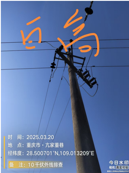
140-41 号杆 T 接杆刀闸锈蚀严重
