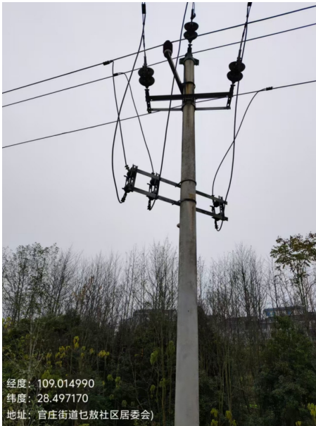
137-2 号杆 跌落保险底座锈蚀严重
