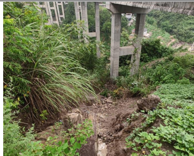
图 4.3.1 沟渠下游桥墩位于沟渠旁
