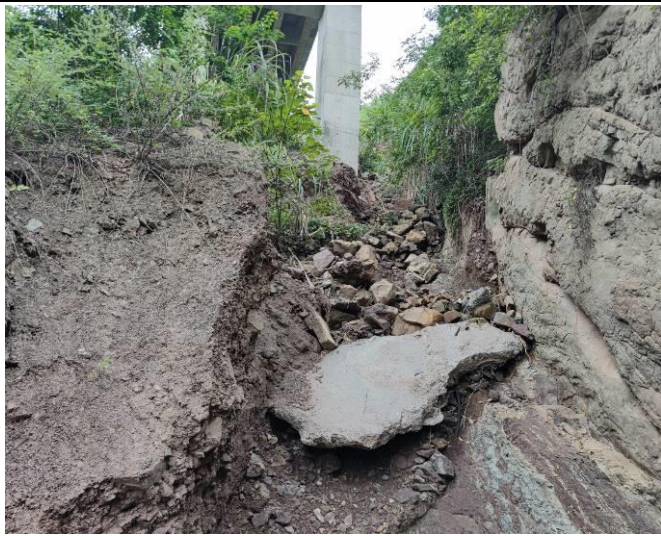
图 4.3.4 沟内堆积大量土石
