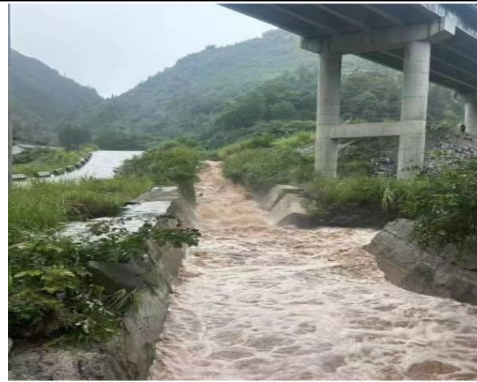
图 4.4.1 雨水沟渠内水流大涨
