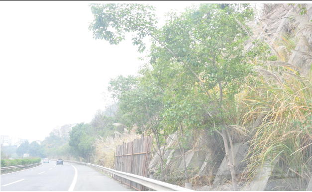
图 3.2.3 边坡现有支护措施
