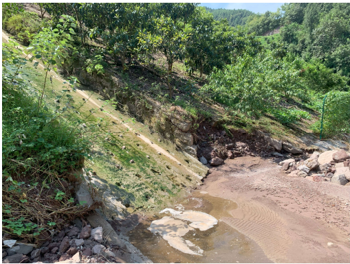
图 3.8.4 (3) 边坡急流槽接排洪渠(一、二段衔接处)
