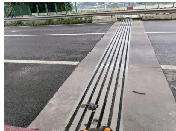
橡胶条老化
