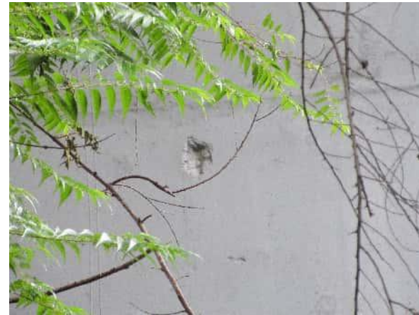
混凝土剥落
