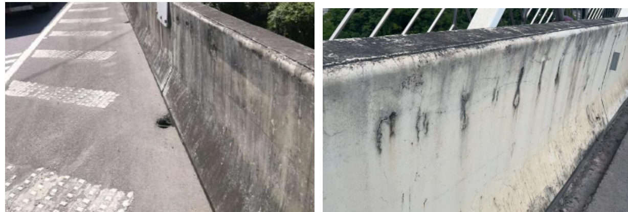
现状混凝土护栏
