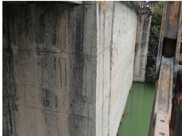
照片 4.2.4-4 18#桥台右侧墙现状
