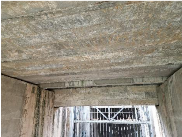
照片 4.1.1-5 1#跨底板现状
