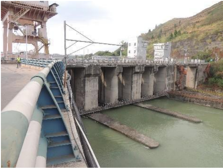
图1.1.3 厂房进水闸桥立面照
