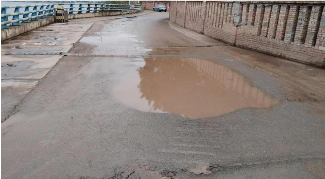
照片4.1.11 引道铺装现状
