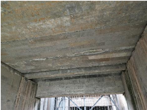
照片 4.1.1-9 5#跨底板现状
