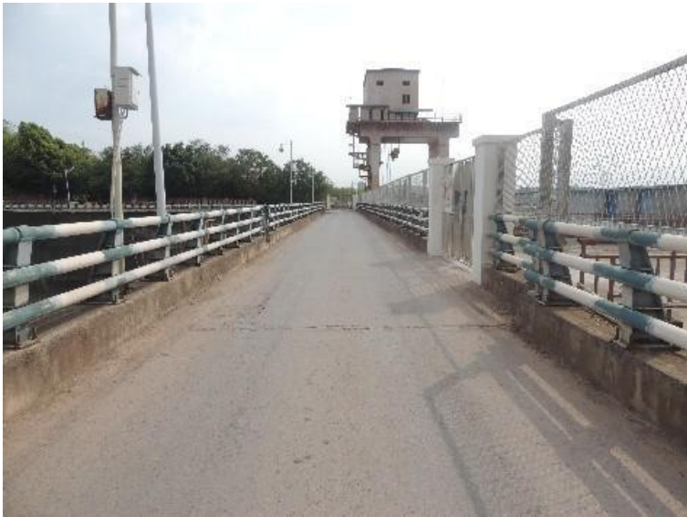
图1.1.2 厂房进水闸桥平面照
