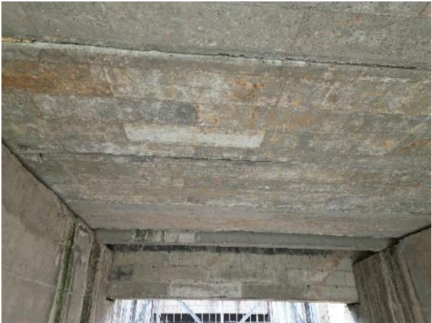
照片 4.1.1-6 2#跨底板现状
