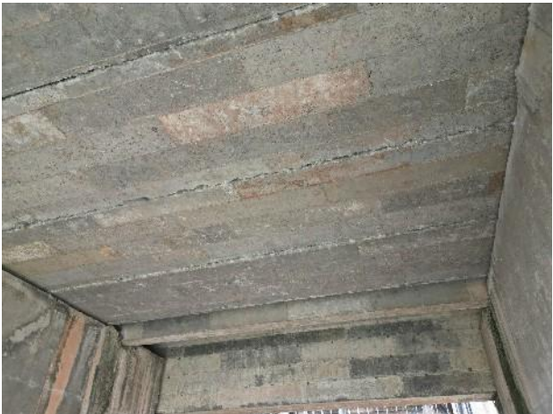
照片 4.1.1-8 4#跨底板现状
