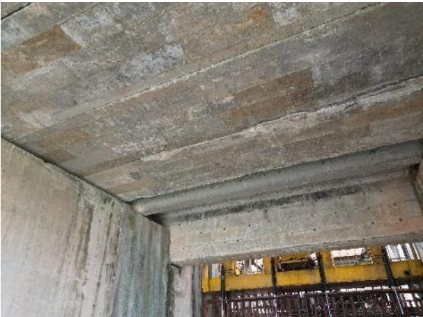
照片 4.1.1-10 6#跨底板现状
