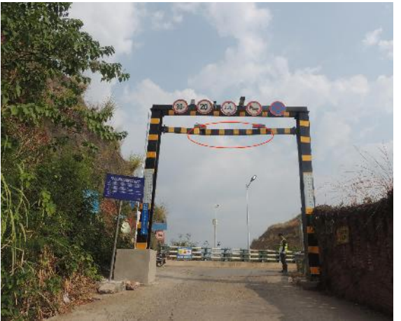
照片 4.1.9-2 限高装置轻微变形
