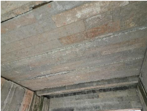
照片 4.1.1-7 3#跨底板现状
