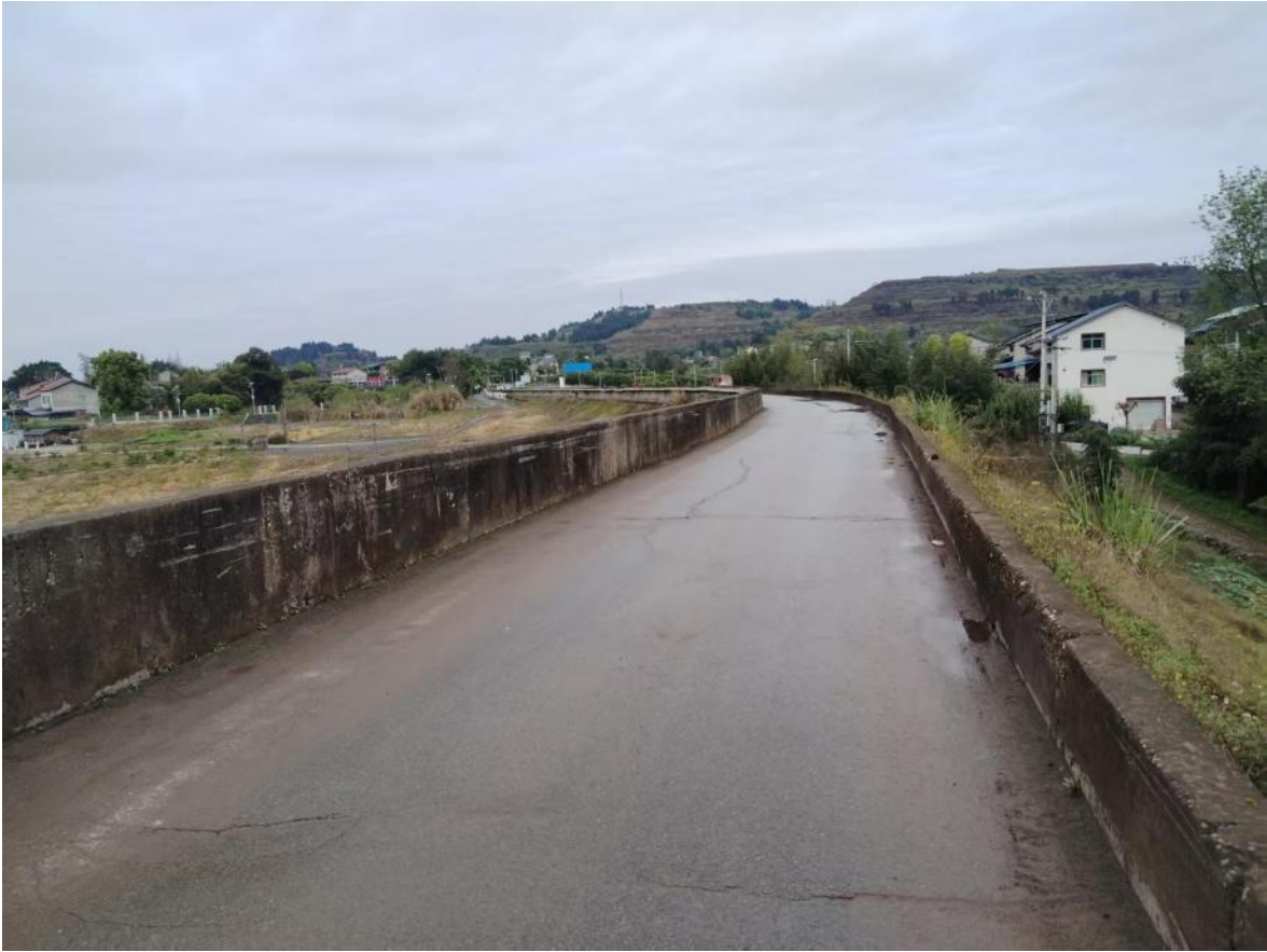
照片4.2.9 现状引道
