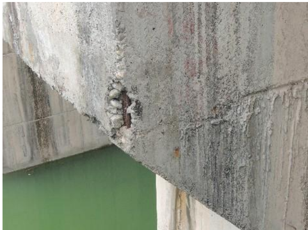
照片 4.2.3-8 10#桥墩施工缝开裂
