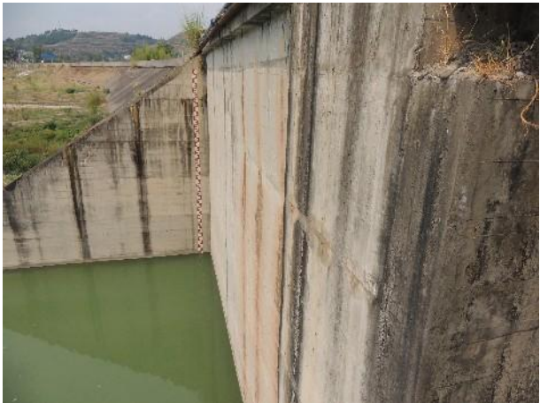
照片 4.2.4-1 0#桥台右侧墙现状
