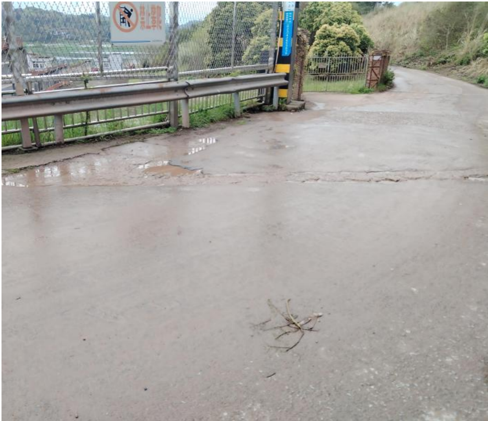
照片4.1.12 引道铺装现状
