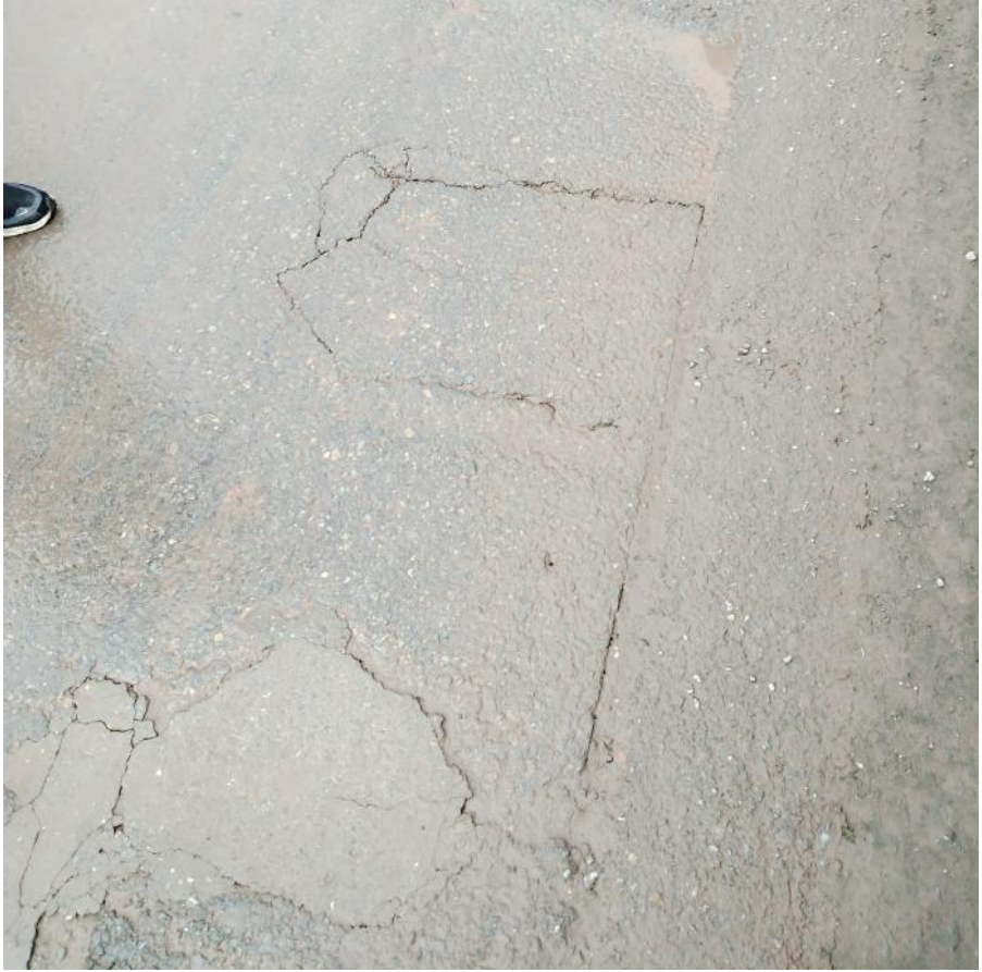
照片4.1.10 电缆沟现状
