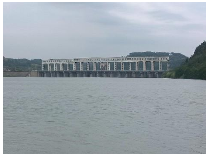
图1.2.3大坝交通桥立面照
