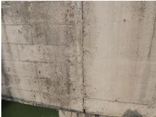
照片 4.2.3-8 10#桥墩施工缝开裂
