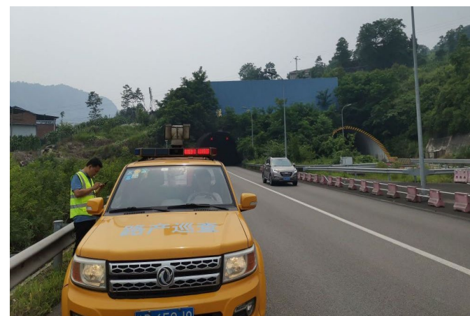
图 4-10 猴子岩隧道出口
