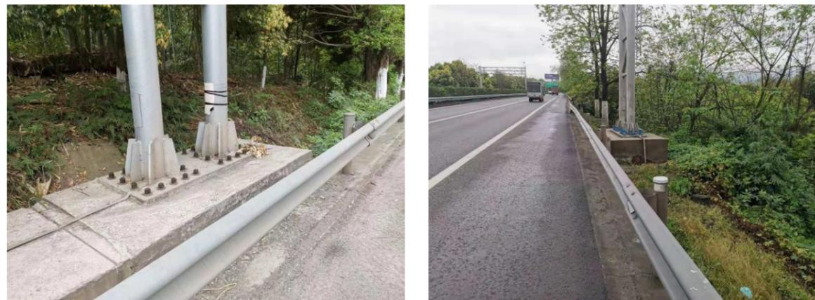
图 1：路肩侧 ETC 门架周围护栏现状
