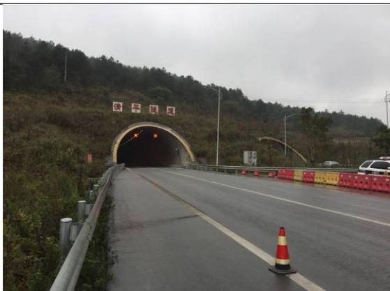
隧道洞口骨架护坡
