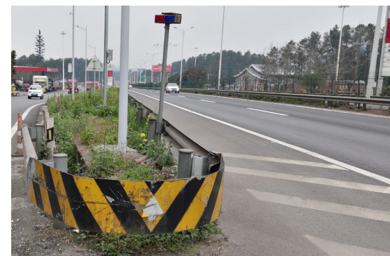
现状本区间段主线波形梁护栏
