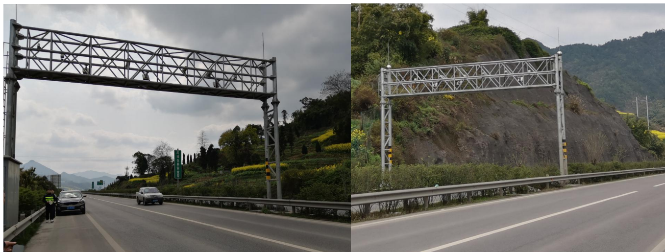
现状 ETC 门架位置护栏防护情况
