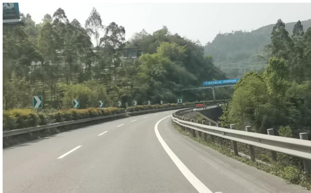
现状本区间段临崖路段路侧波形梁护栏
