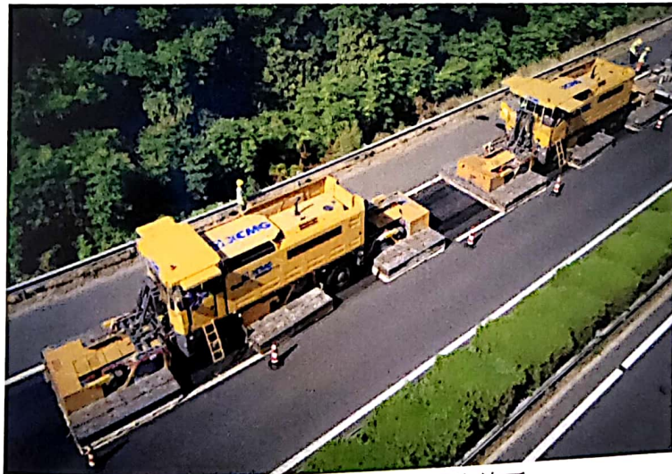
G2513 淮徐高速就地热再生施工
