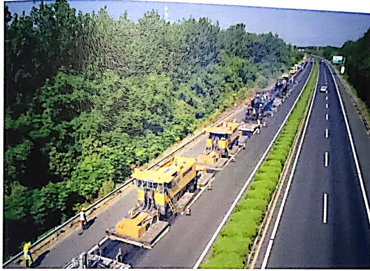
S49 新扬高速就地热再生施工
