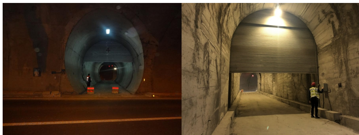
图 1.3-2：奉巫路部分隧道现场调查情况
