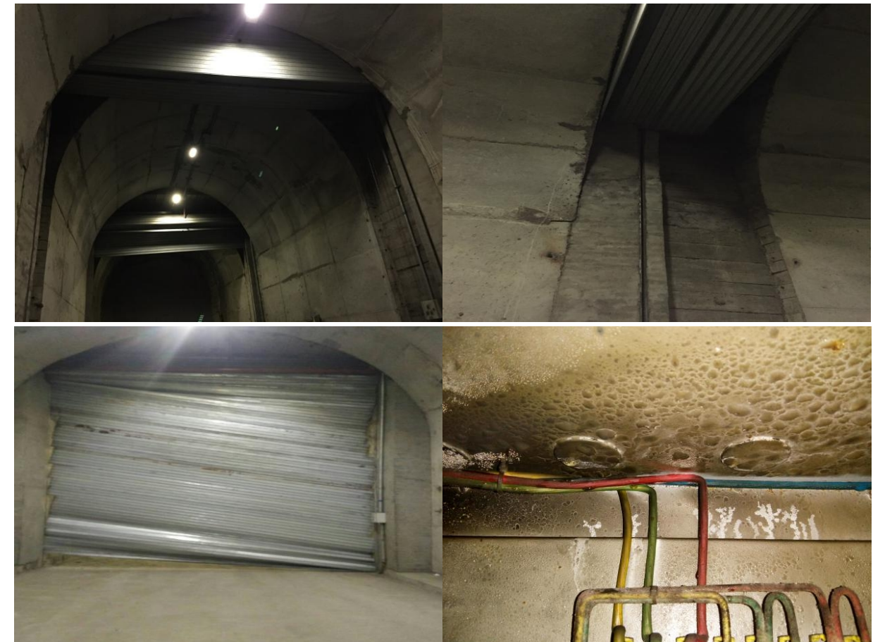
图 1.3-1：奉溪路部分隧道现场调查情况
