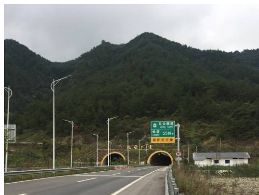
隧道洞口骨架护坡
