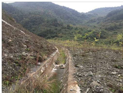
弃渣场排水沟
