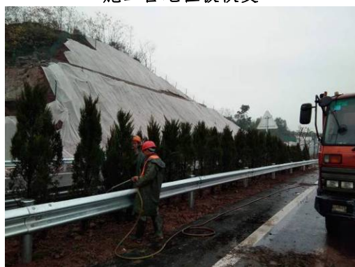
道路边坡临时覆盖
