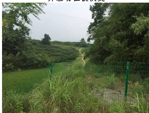
施工便道植被恢复
