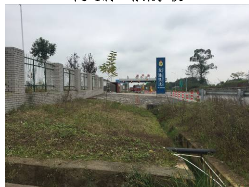
沿线设施区排水沟
