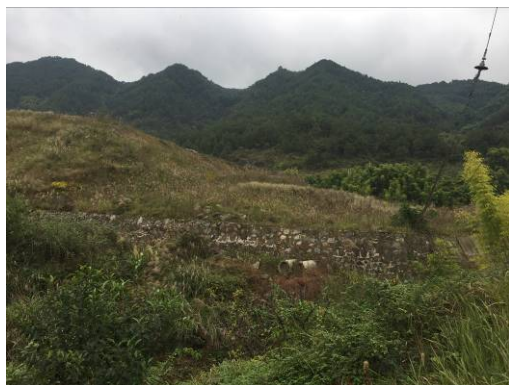
弃渣场挡渣墙
