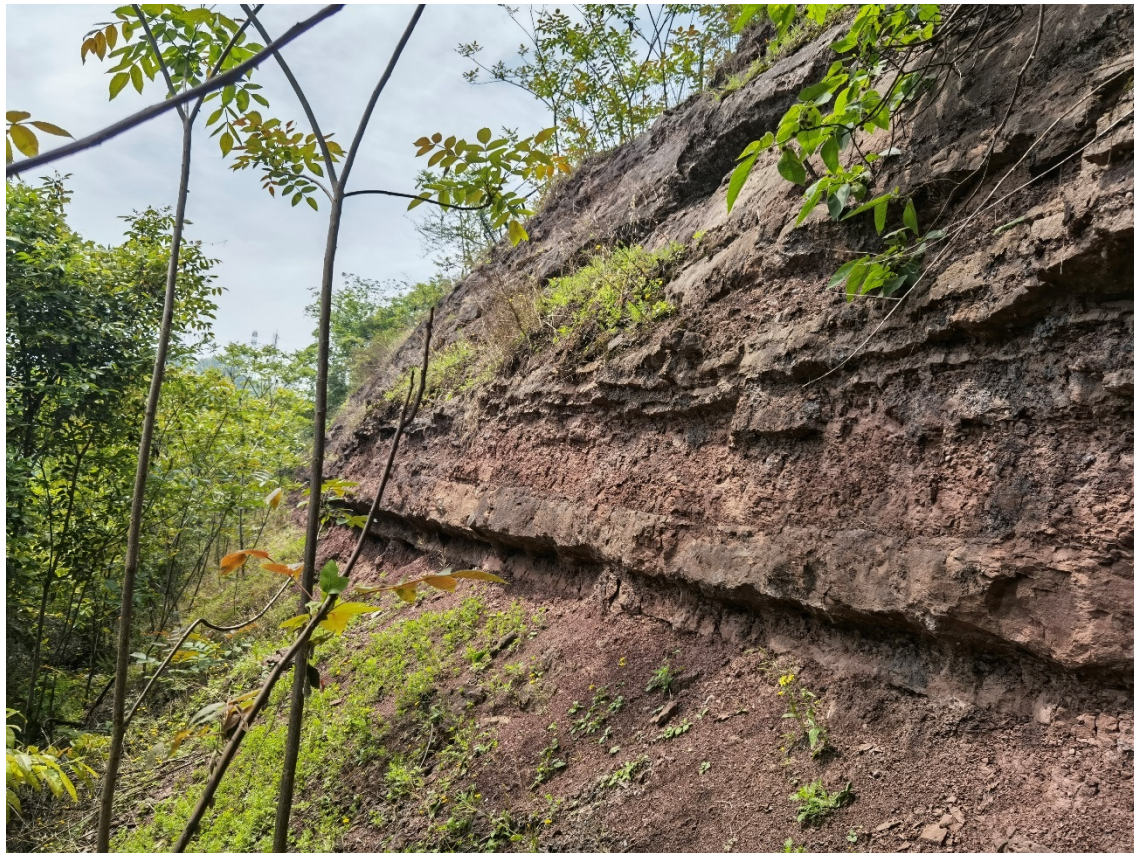
二级边坡风化情况
