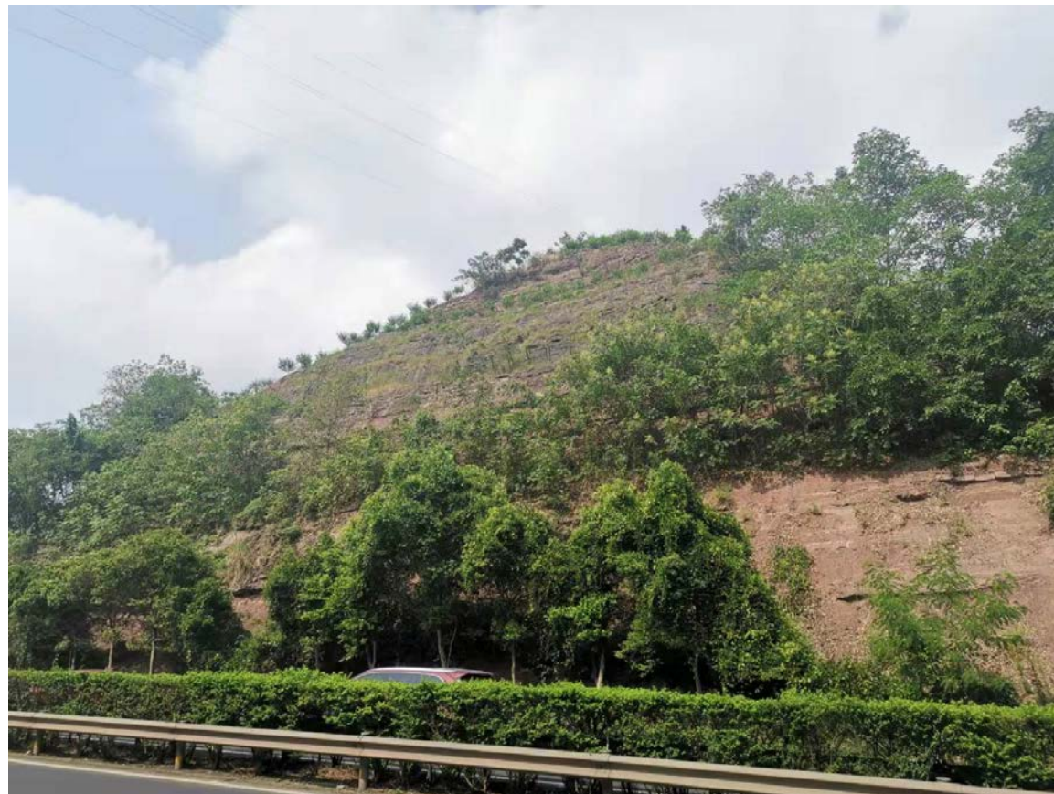
边坡整体状况
