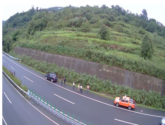
图 6-4-6 K19+800 左侧边坡防护
