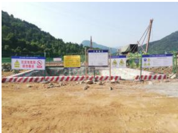
图 8-2-1 沉淀池现场照片
