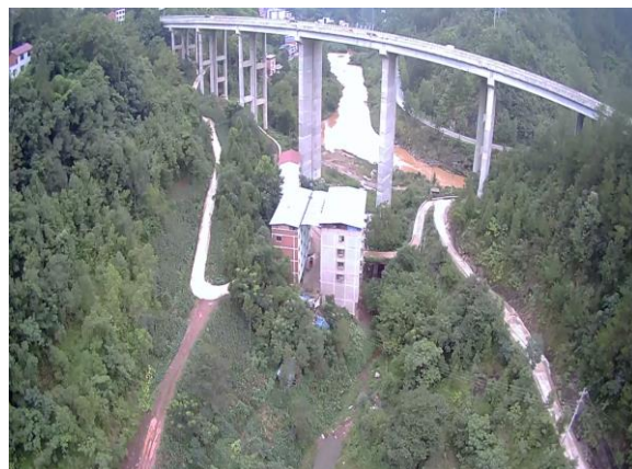
图 6-4-4 施工便道恢复为地方道路
