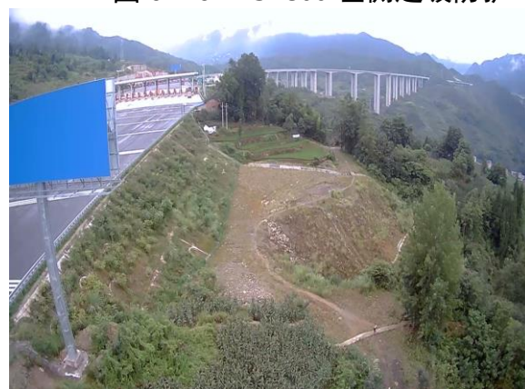
图 6-4-8 K47+350 右侧边坡防护
