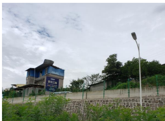
图 7-3-3 围墙现场情况
