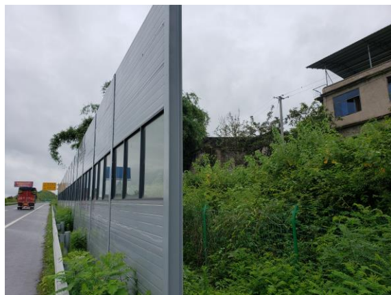
图 7-3-4 声屏障现场情况
