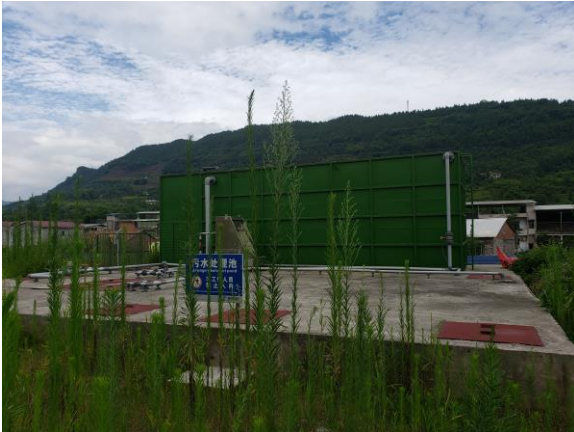
图8-3-5歇凤服务区污水处理设施
