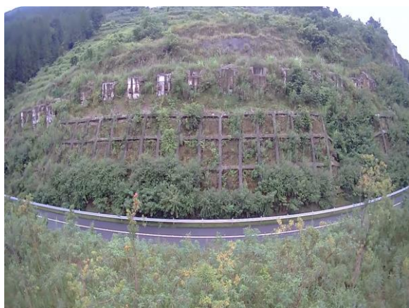
图 6-4-5 K27+400 左侧边坡防护
