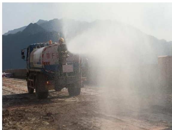
图9-1-2 洒水车现场洒水
