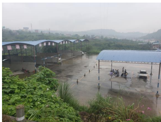
图 6-4-5 施工营地改建为驾校
