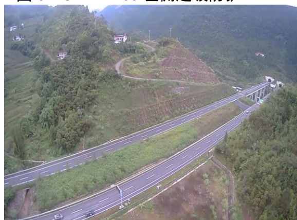
图 6-4-7 K32+500 右侧边坡防护
