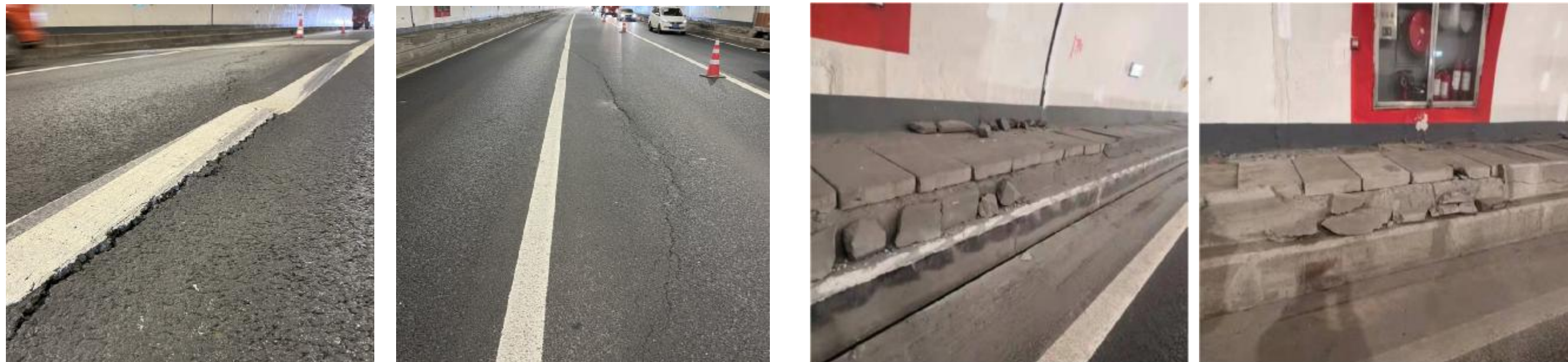
图 8-2 检修道及电缆沟倾斜、破损病害
