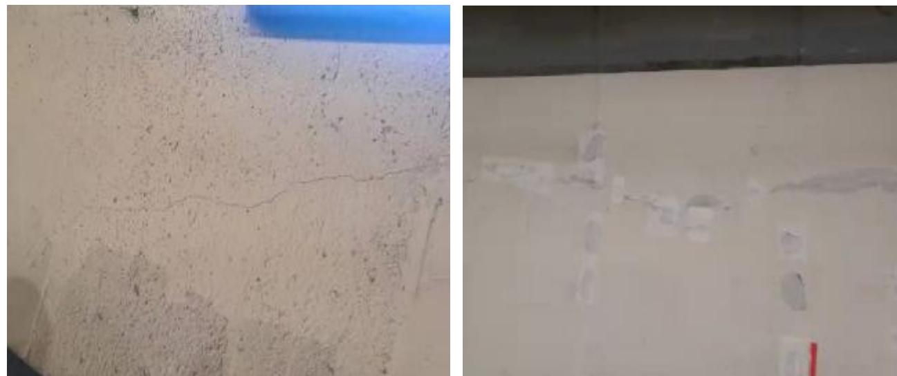
图 8-2 检修道及电缆沟倾斜、破损病害
