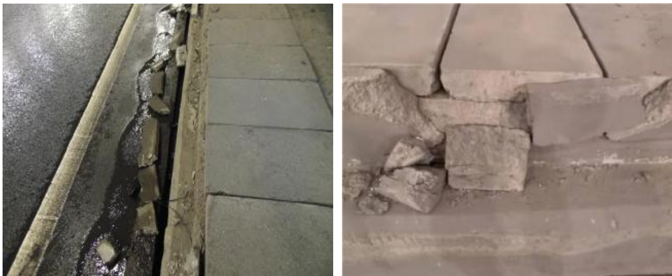
图 8-1 路面纵向裂缝、错台病害
