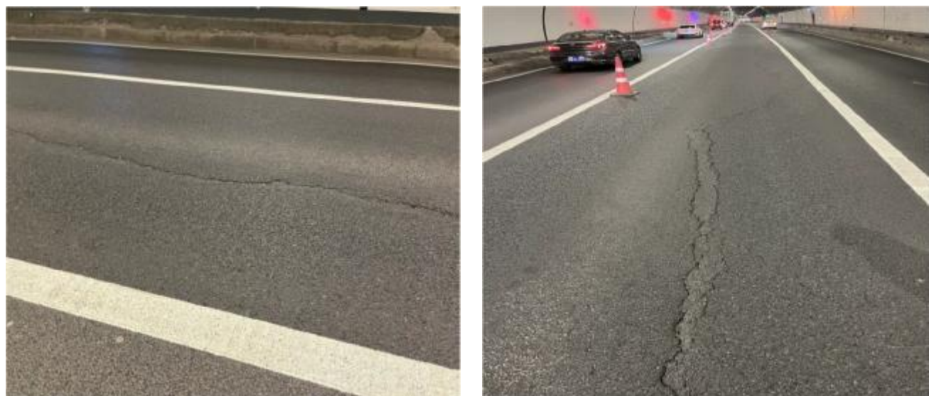
图 8-1 路面纵向裂缝、错台病害
