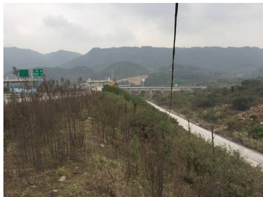
路堤边坡绿化
