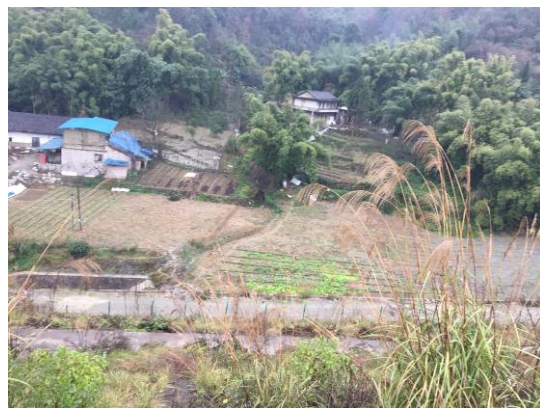
施工场地及施工营地区复耕
