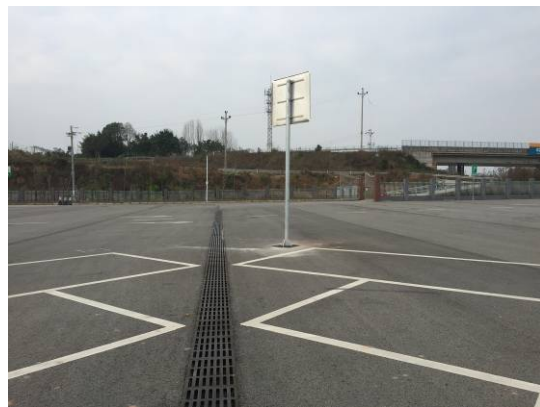
辅助工程区排水沟
