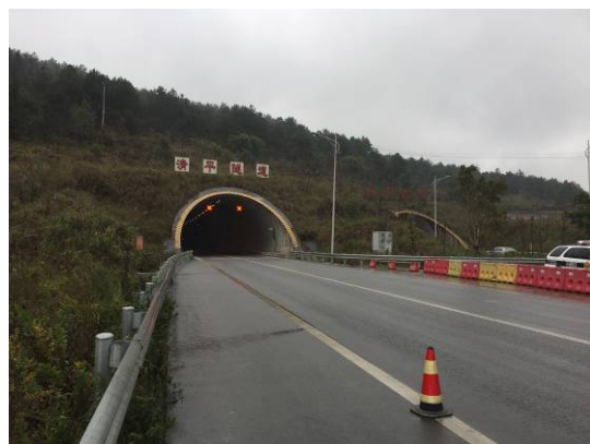
隧道洞口骨架护坡
