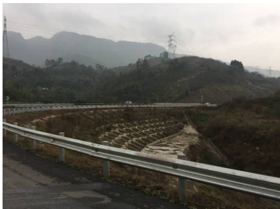
路基骨架护坡
