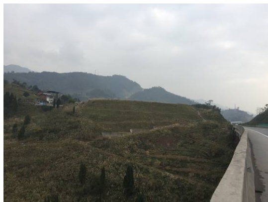
弃渣场植被恢复
