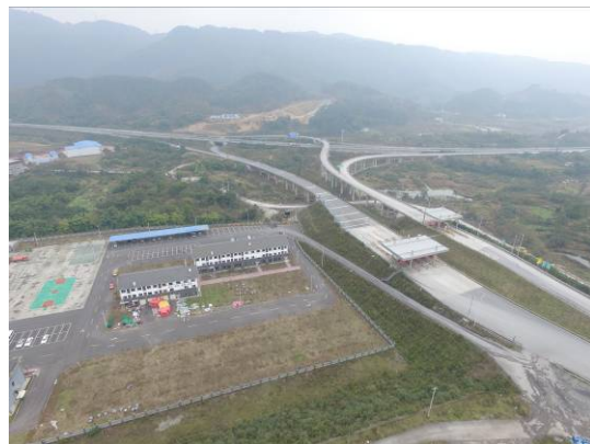
交叉工程区绿化
