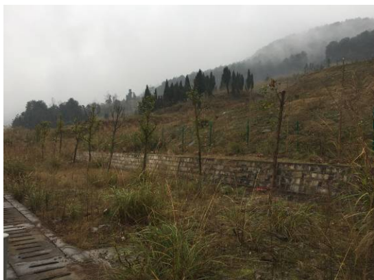
弃渣场挡渣墙
