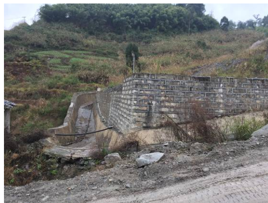
弃渣场排水沟
