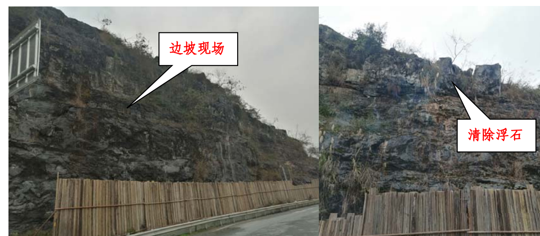
图 1-2 边坡现场照片
