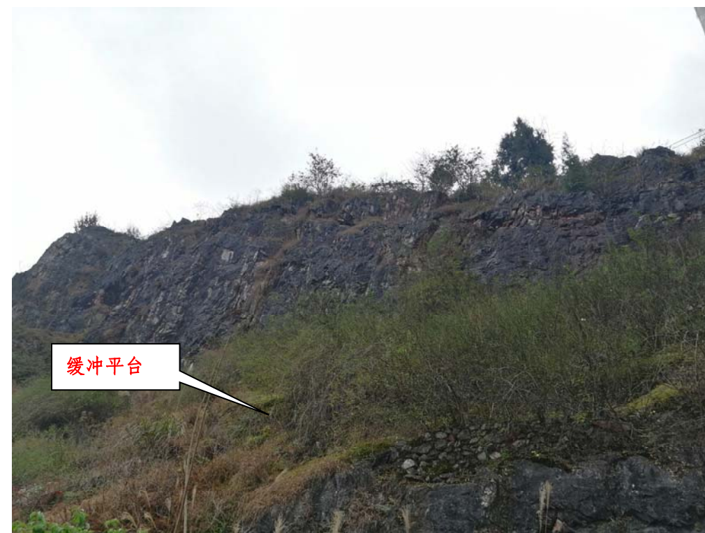
图 2-3 边坡现场照片
