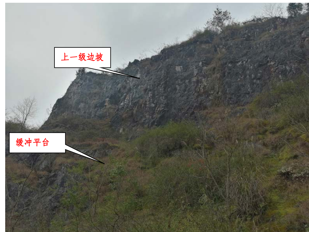
图 2-2 边坡项目现状
