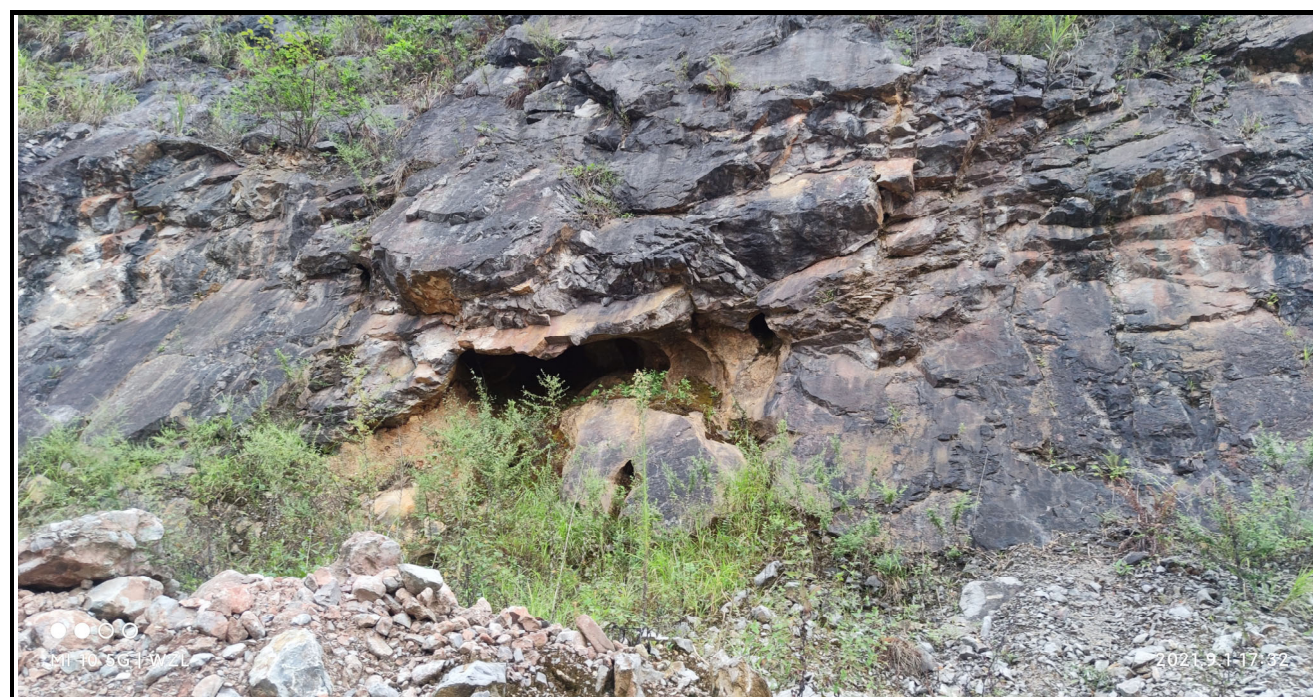
图 4.1-1 临近边坡揭露溶洞顺层发育照片
