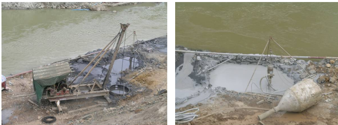
图 5.2.1-1 桥梁灌注桩基钻渣收集处理流程图
