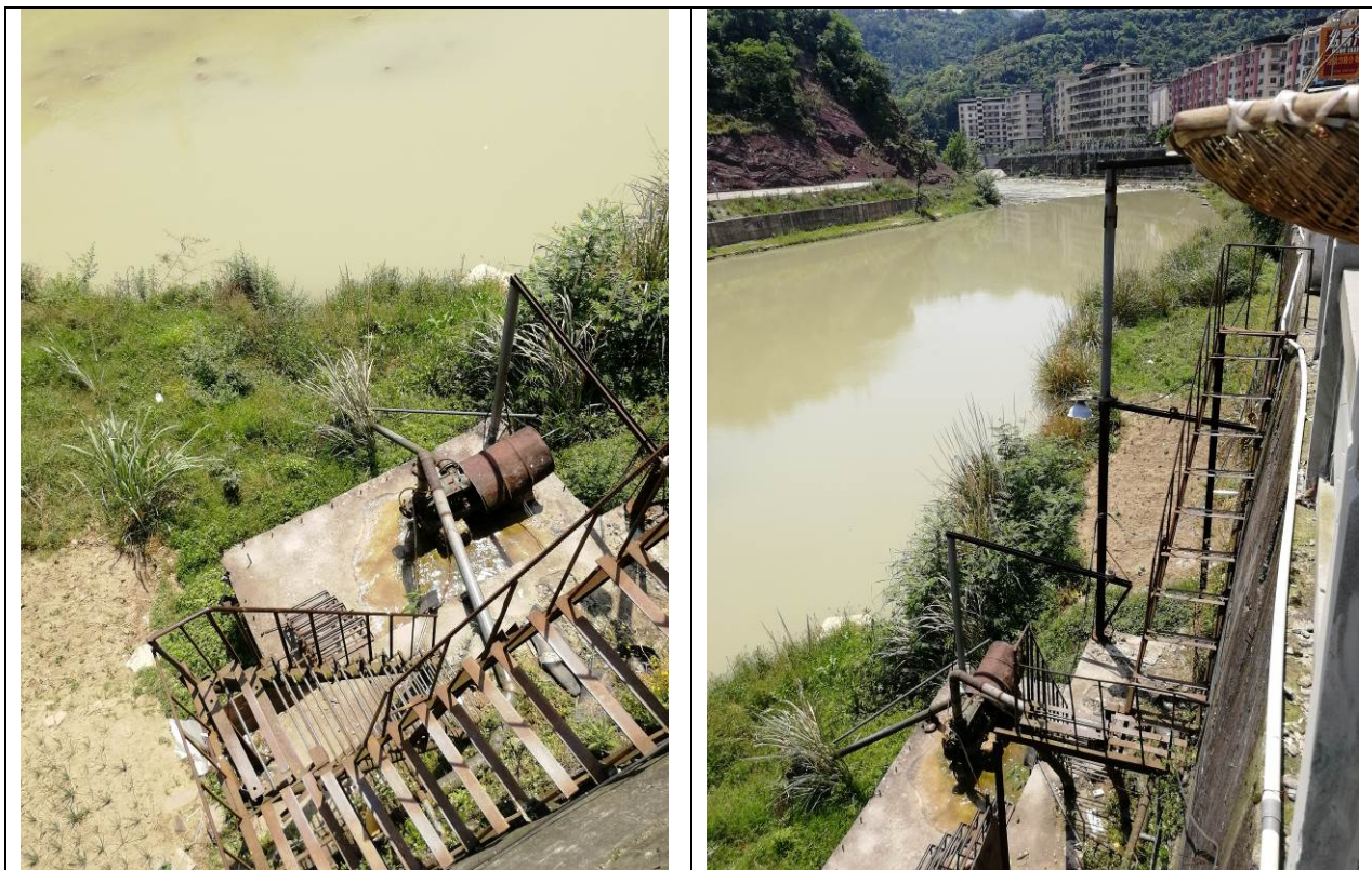
图 5.2.2-1 江口供销社水厂取水现状
