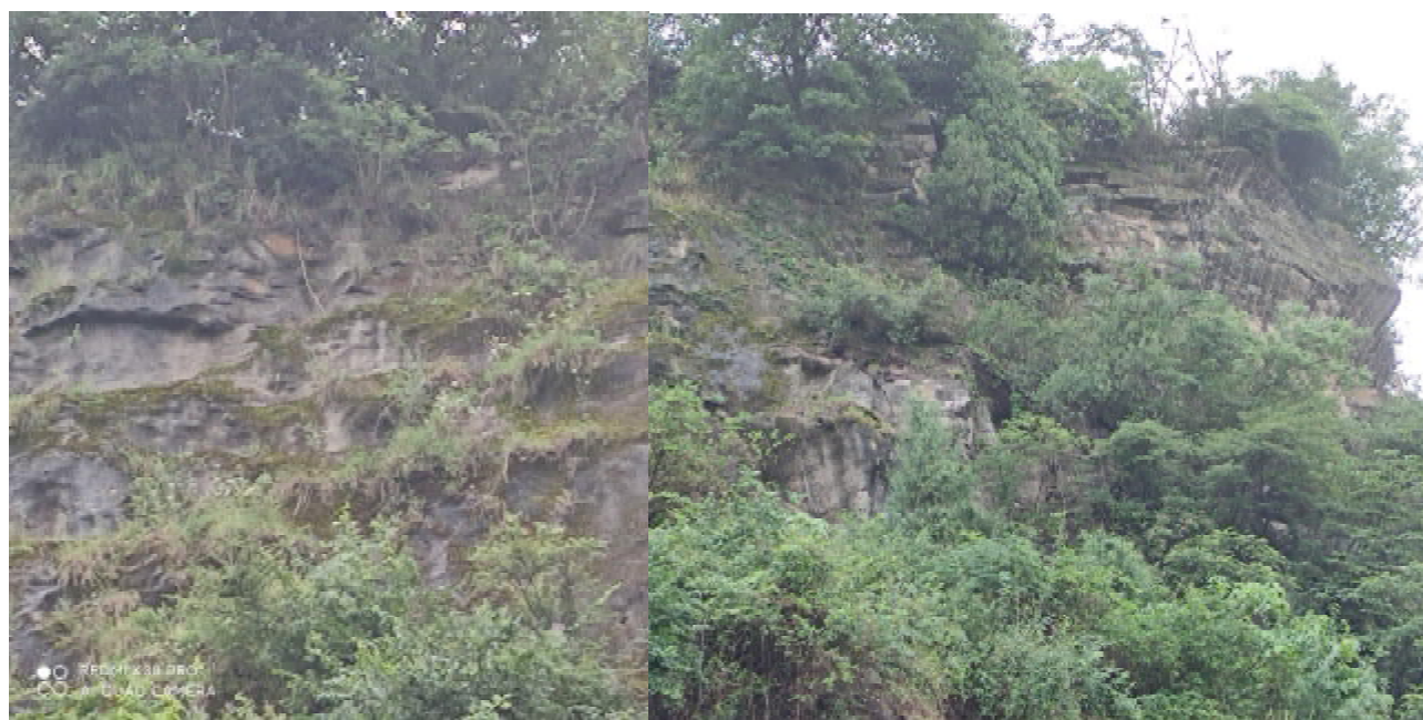
照片 3.1 坡顶分布多处危岩体
