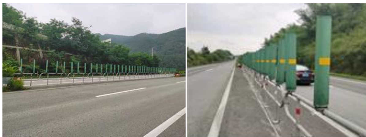
图 1 梁忠高速中分带开口现状
