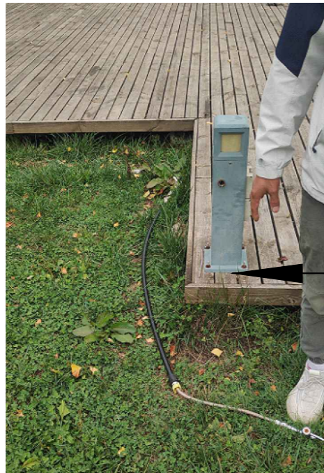
房车营地改造内容：新建地上式井 做法：砌体结构
