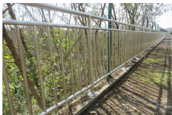
图 4.9-4 右侧不锈钢栏杆现状
