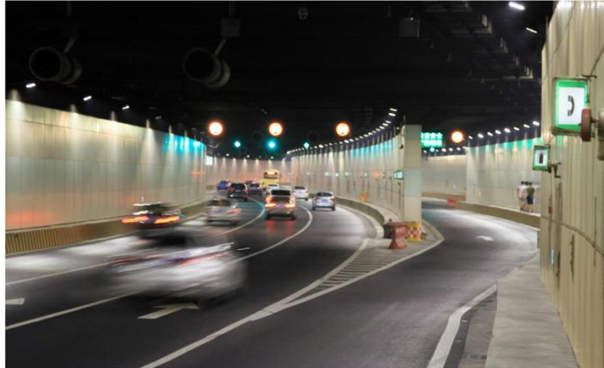
图 5-1 成都市红星路南延线下穿隧道采用秀壁板装饰
