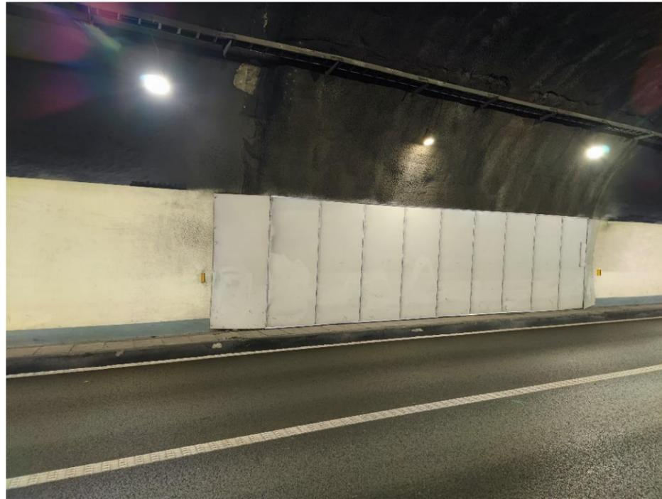
图 1-6 钢骨架加固段侧壁装饰
