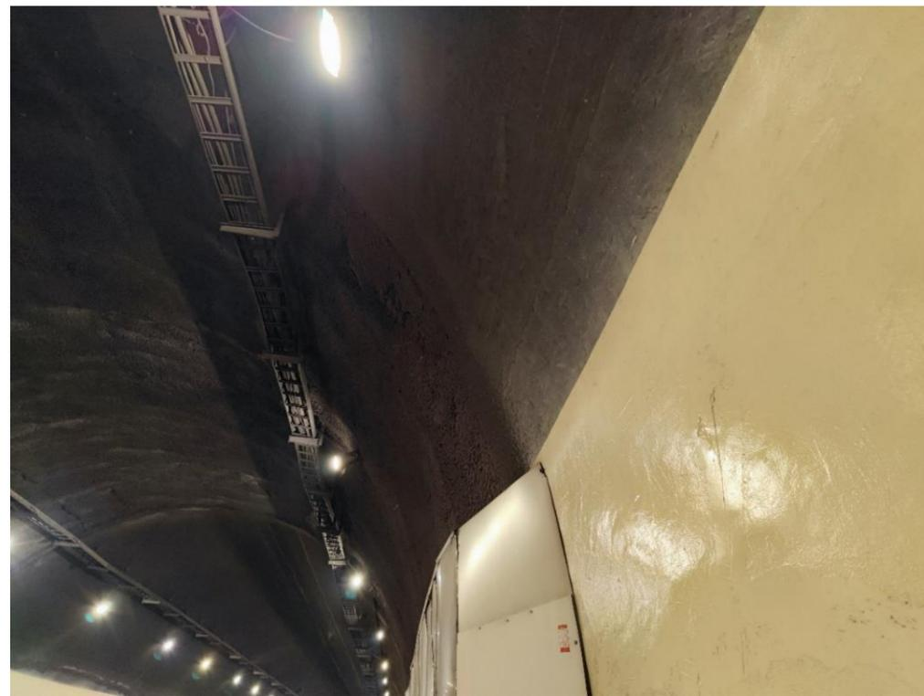
图 1-3 隧道内壁采用工字钢+喷射混凝土处置区段
