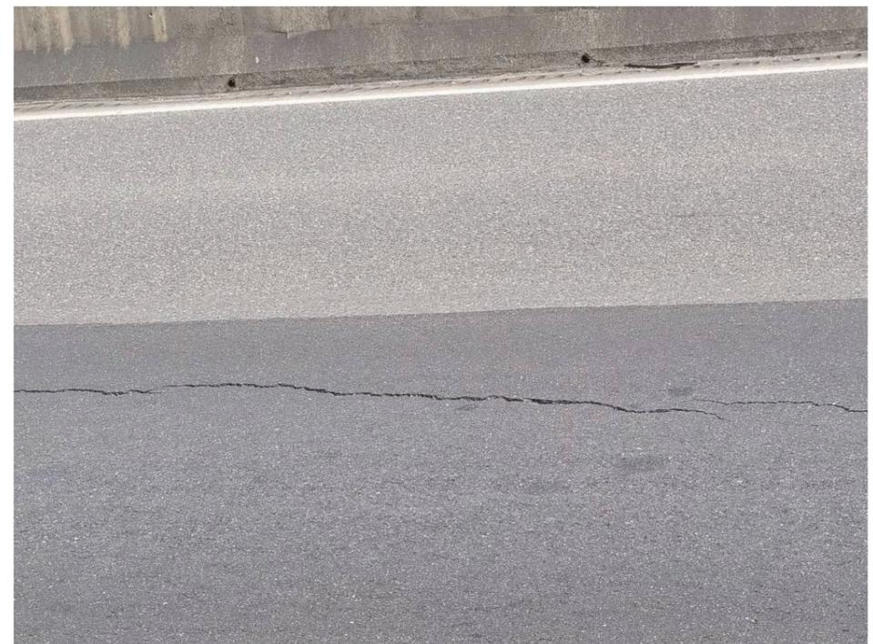
图 4.1-4 纵向裂缝
