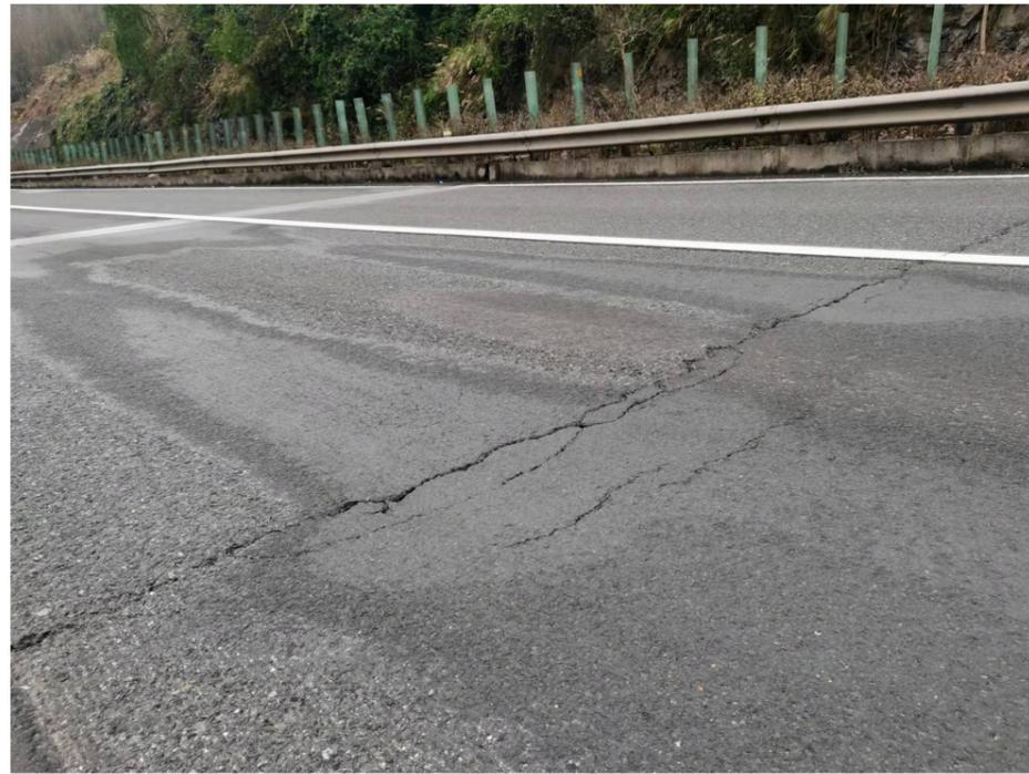
图 4.1-1 裂缝、破损
