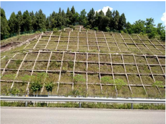
挖方边坡框格护坡（运行期）
