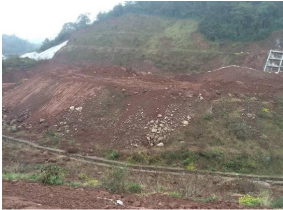
互通立交回填边坡坡底排水沟
