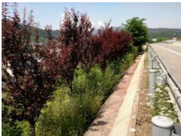
图 6-4-7 K10 右侧边坡防护
