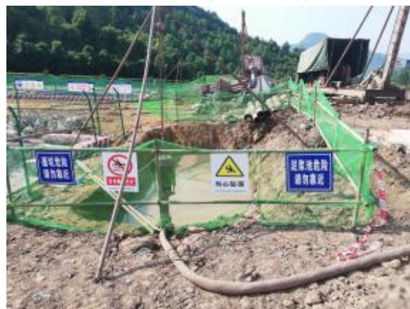
图 8-2-2 泥浆池现场图片
