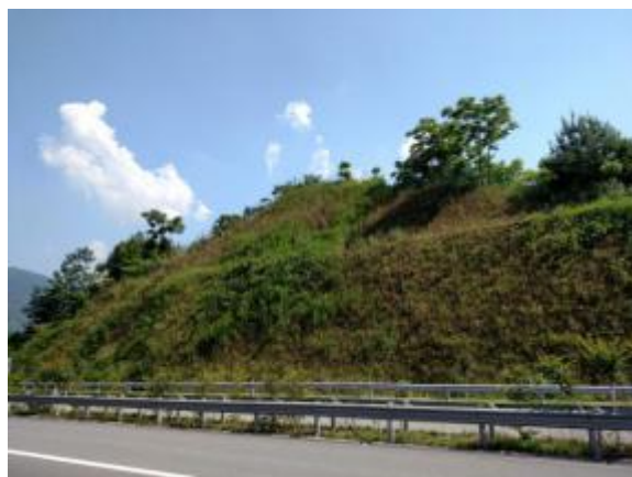
图 6-4-6 K24 左侧边坡防护
