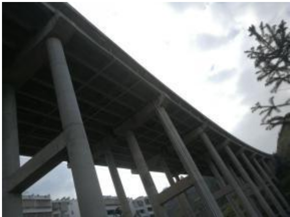
图 8-3-4 石碗溪大桥桥面径流
