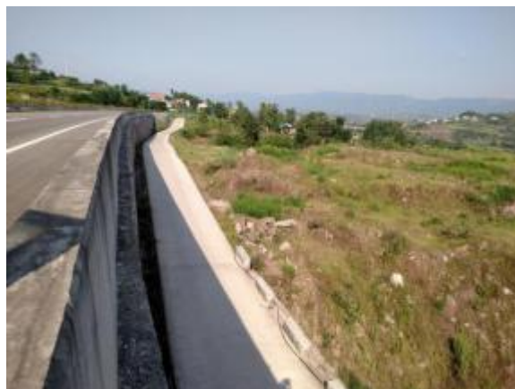
图 6-4-4 施工便道恢复为地方道路
