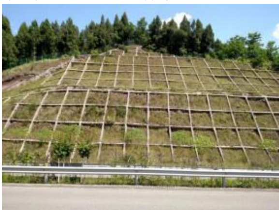
图 6-4-5 K12+600 左侧边坡防护
