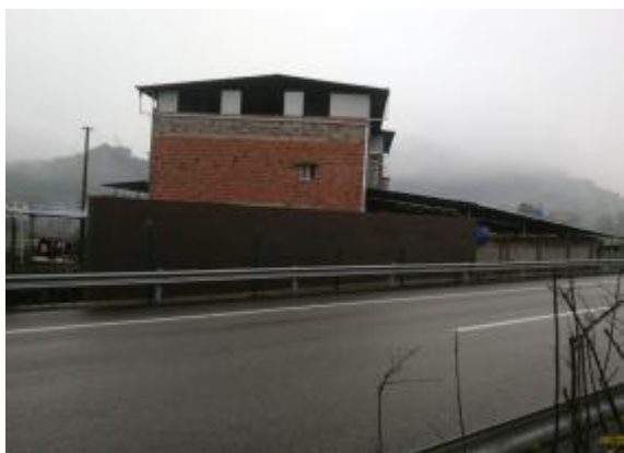
图 7-3-3 李家院子围墙现场情况
