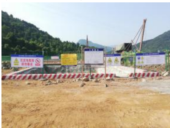
图 8-2-1 沉淀池现场照片
