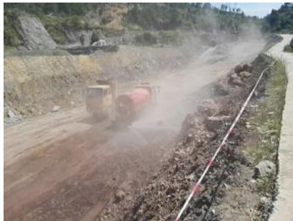
图9-1-2 洒水车现场洒水
