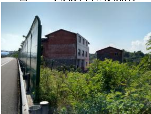
图 7-3-5 山家院子声屏障现场情况
