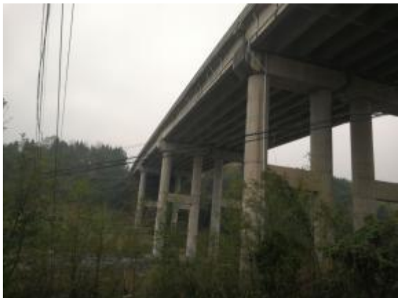
图 8-3-5 南河大桥桥面径流
