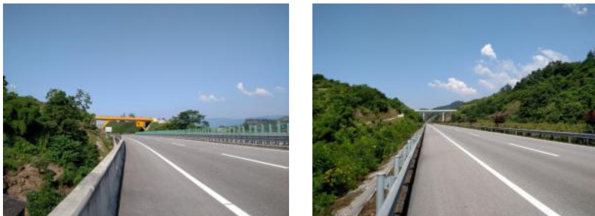
图 5-3-1 工程设置的通行设施的情况
