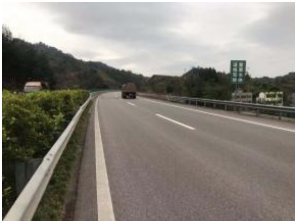
图 8-3-3 南河大桥上方警示牌
