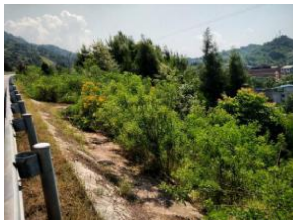
图 6-4-8 K15 右侧边坡防护
