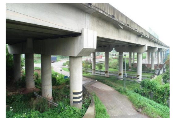
照片 3-1-4 铜梁西特大桥立面照
