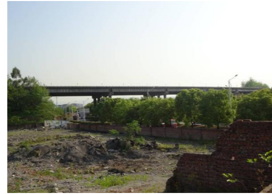
照片 3-2-2 白鹤嘴小桥立面照
