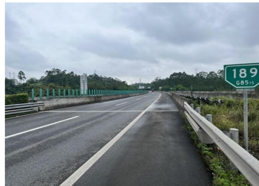
照片 3-5-1 双石互通主线 1 号桥正面照
