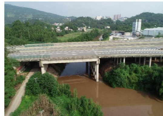
照片 3-5-2 双石互通主线 1 号桥立面照
