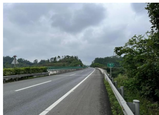
照片 3-4-1 青岗咀大桥正面照
