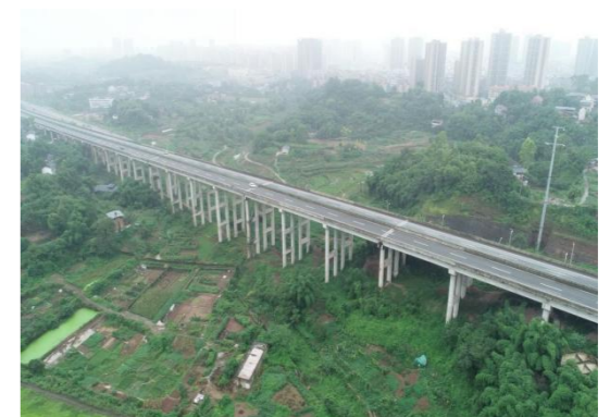
照片 3-1-2 铜梁西特大桥整体照
