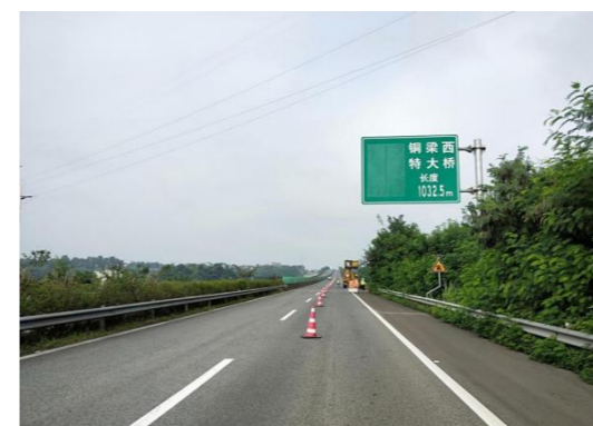
照片 3-1-3 铜梁西特大桥正面照
