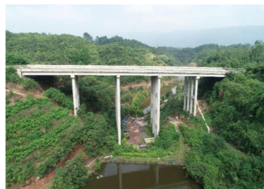
照片 3-4-2 青岗咀大桥立面照
