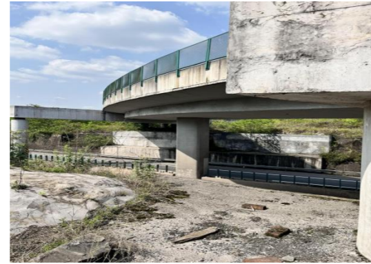
照片 3-6-2 双石互通 G 匝道 2 号桥立面照
