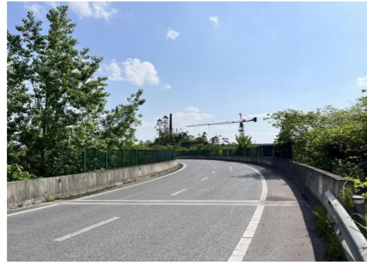
照片 3-6-1 双石互通 G 匝道 2 号正面照
