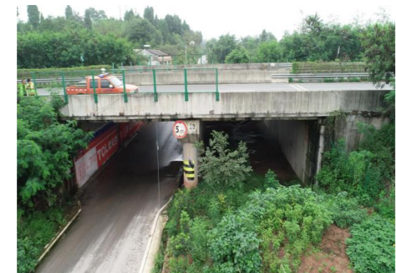
照片 3-3-2 K143+550 桥式通道立面照
