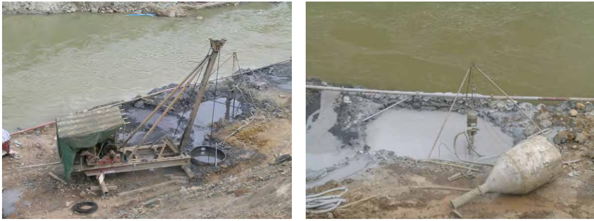
图 5.2.1-2 桥梁灌注桩基钻渣泥浆收集处理及利用
