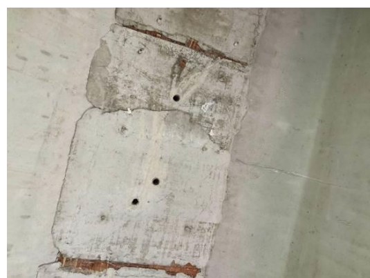
图 3.1-4 4-3#湿接缝裂缝
