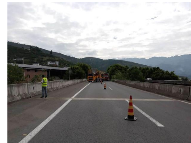
图 1.2.3-2 草堂河大桥右线I号桥桥面照
