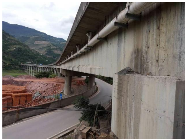
图 1.2.4-1 草堂河大桥（左线）立面照
