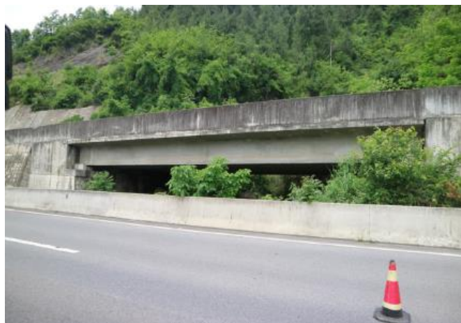
图 1.2.6-1 大块田 2 号中桥立面照
