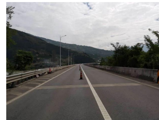
图 1.2.5-2 草堂河大桥右线II号桥桥面照
