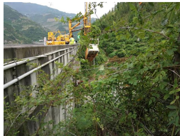
图 1.2.3-1 草堂河大桥右线I号桥立面照
