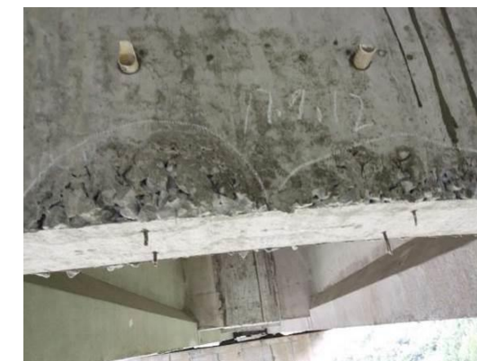
图 3.2-4 L10-2-4#横隔板底面蜂窝、麻面
