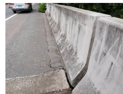
图 3.3-5 R1#台身右侧侧墙位移
