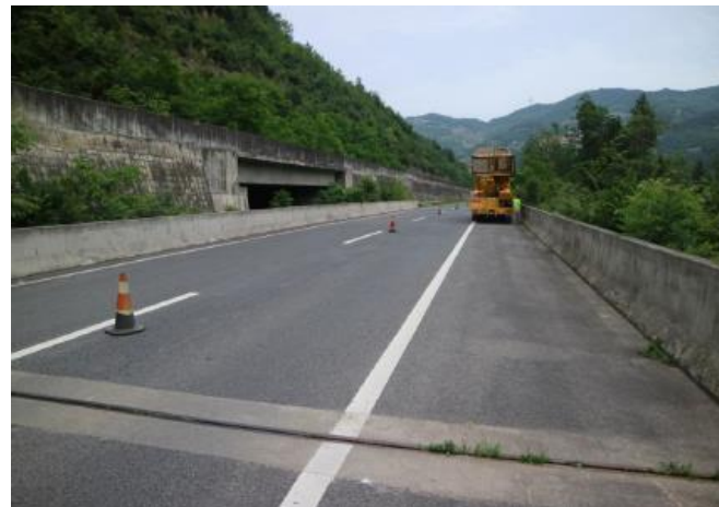
图 1.2.6-2 大块田 2 号中桥桥面照
