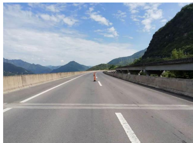
图 1.2.2-2 香家坪大桥桥面照
