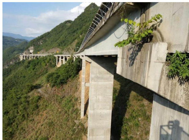
图 1.2.1-1 小溪河特大桥立面照
