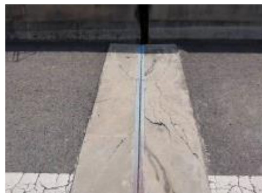
图 3.12-2 R3#伸缩缝锚固区缺陷破损
