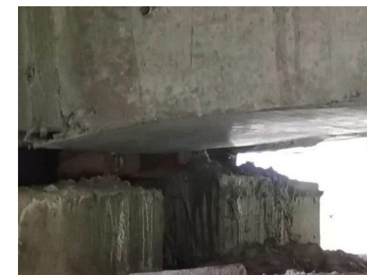
图 3.2-6 L-6-6-5#支座左侧剪切变形
