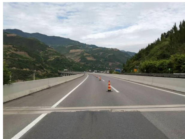
图 1.2.4-2 草堂河大桥（左线）桥面照
