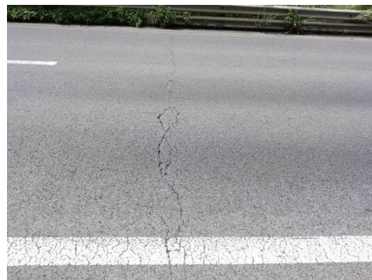
图 3.5-7 R0#台身横向裂缝
