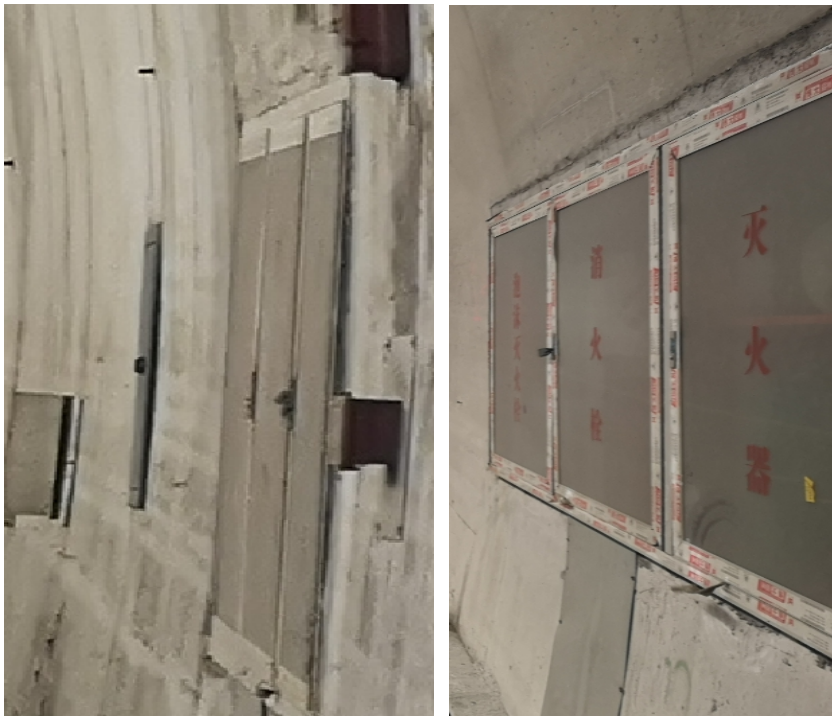
图 1.4-2：隧道内消防箱门现状
