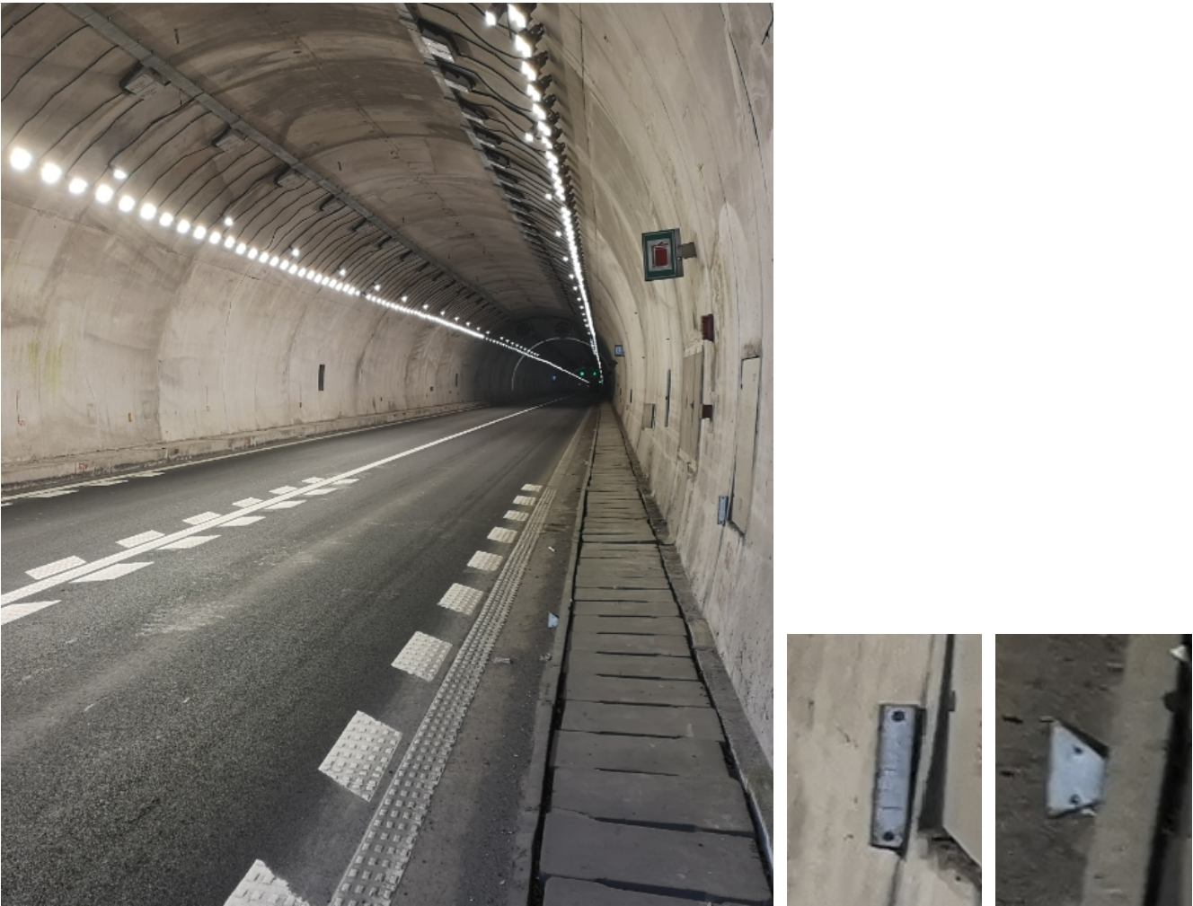
图 1.4-1：隧道洞内反光设施现状
