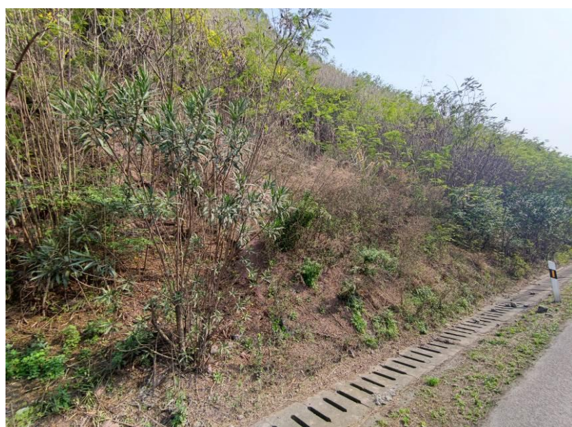
图 4-1 边坡坡脚全景
