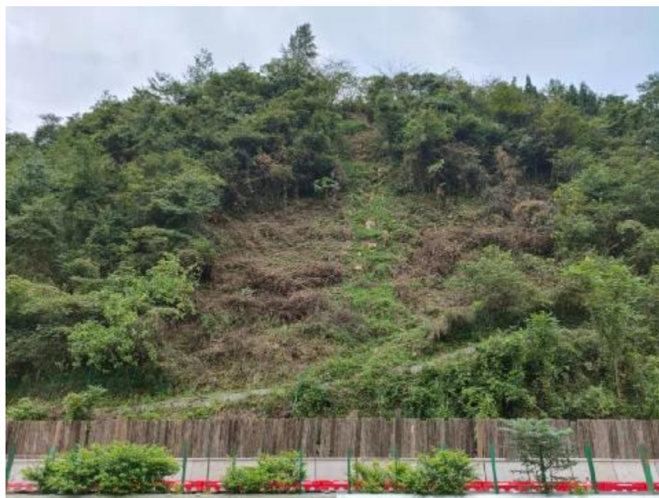
现场边坡照片
