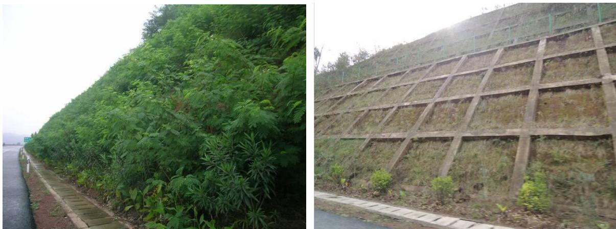
图 6-3-1 工程边坡防护现场情况
