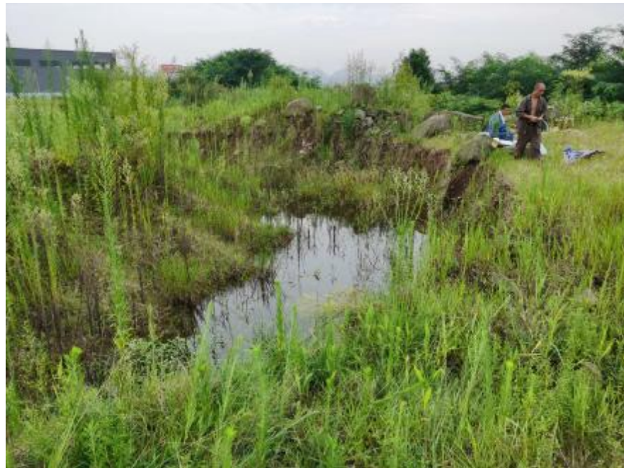
照片 3.6-1 边坡后缘凹槽地表水
