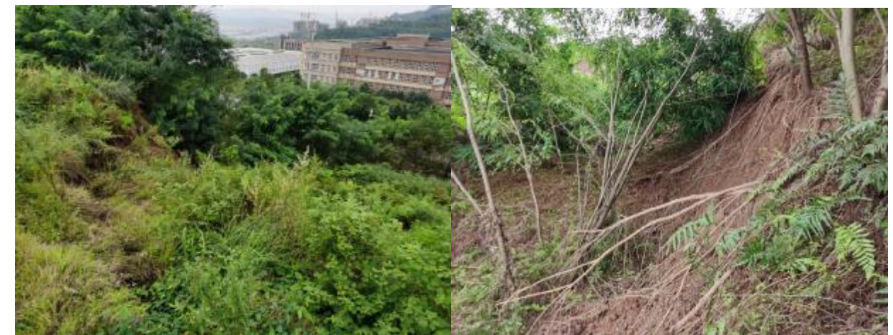
照片 4.2-2 边坡滑塌区后缘陡坎
