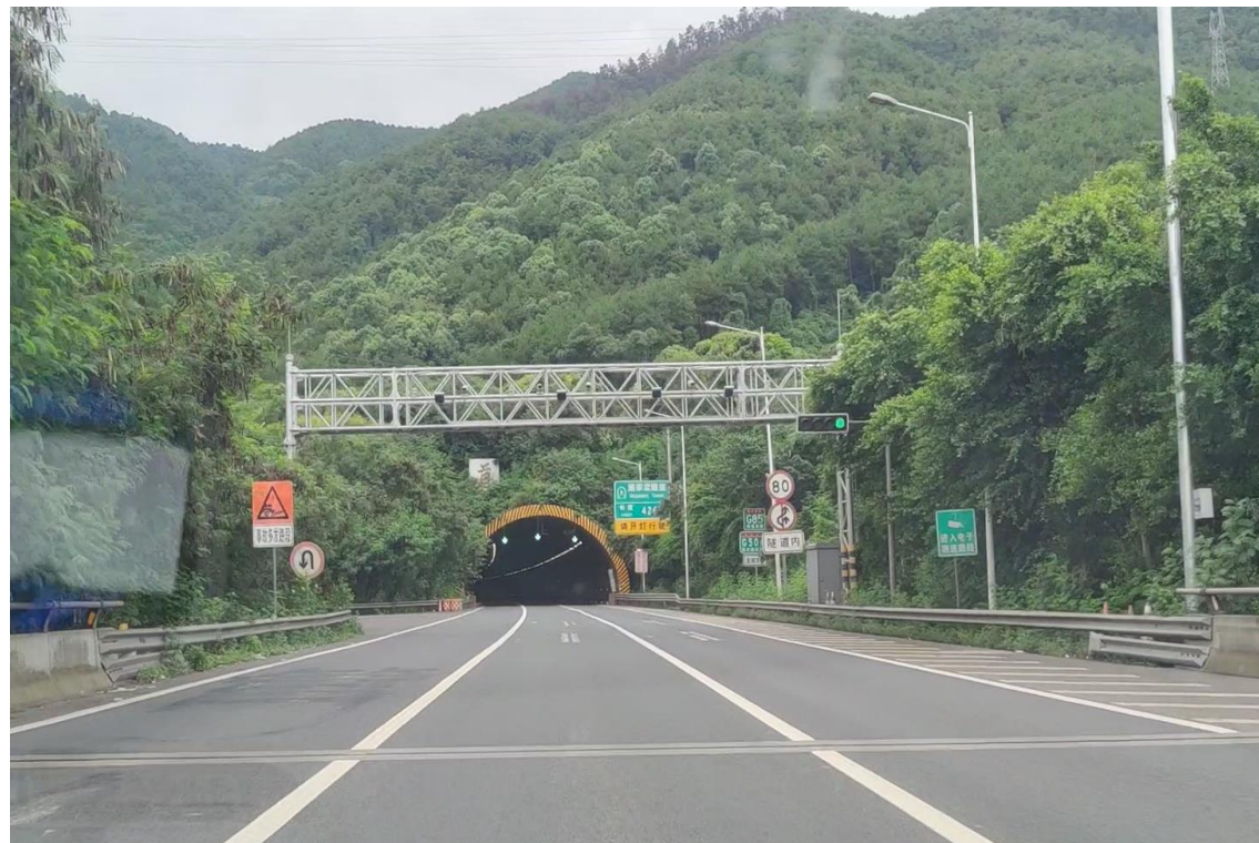
ETC门架搭接桥梁护栏和隧道入口
