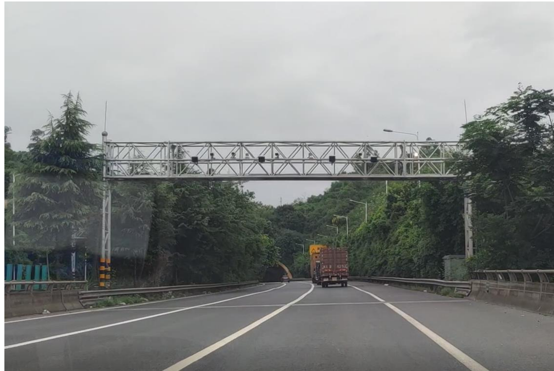
ETC门架一端搭接桥梁护栏
