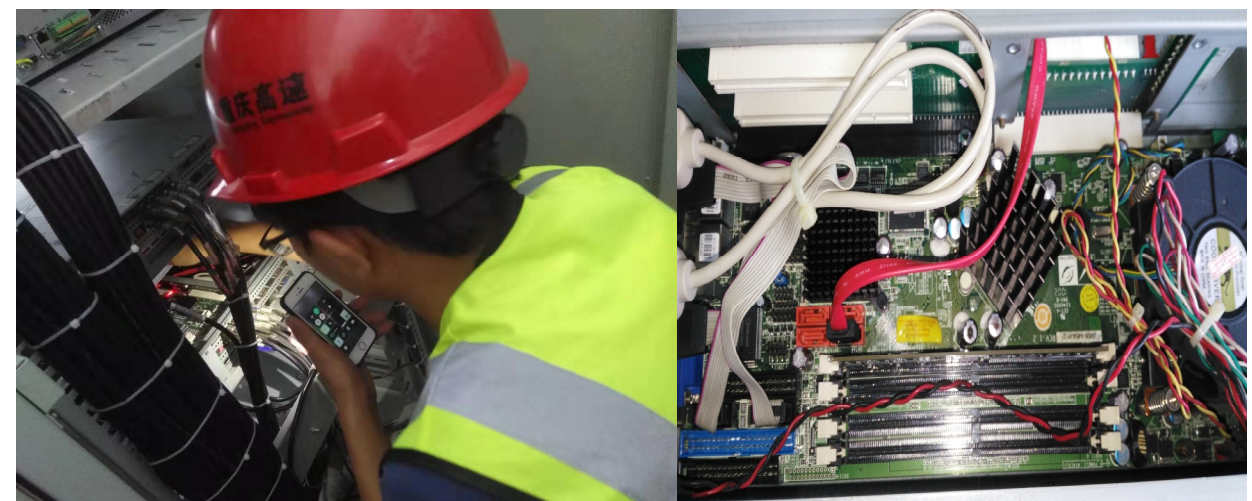
图 1.1-2: 云奉路事件检测仪检修情况
