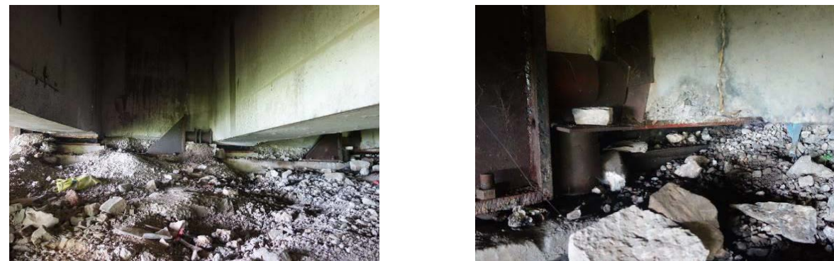
图 1.3-1 设置横向限位装置
