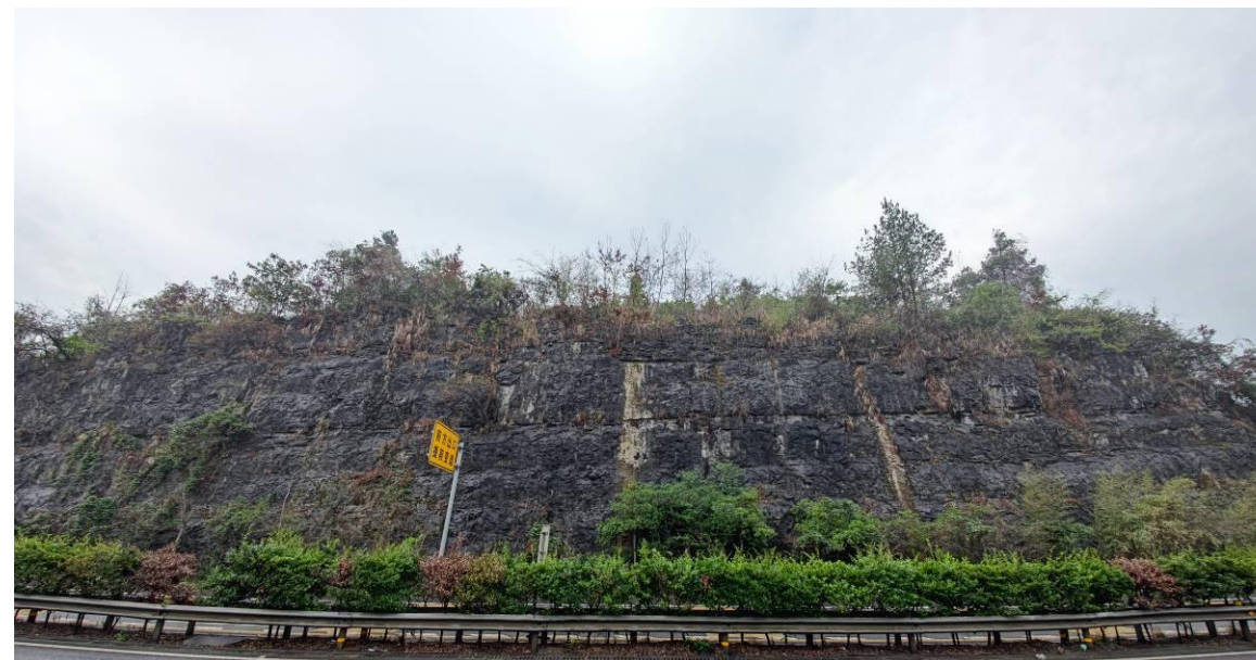
图 1.2 边坡正面全景照片
