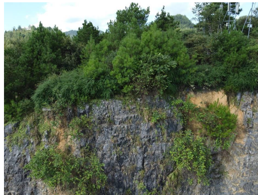
图 1.3 边坡顶部溶隙内充填物
