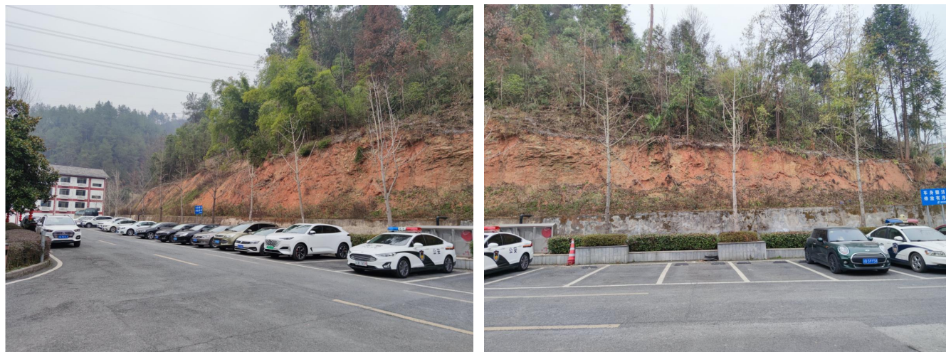
图 1 边坡正面情况
