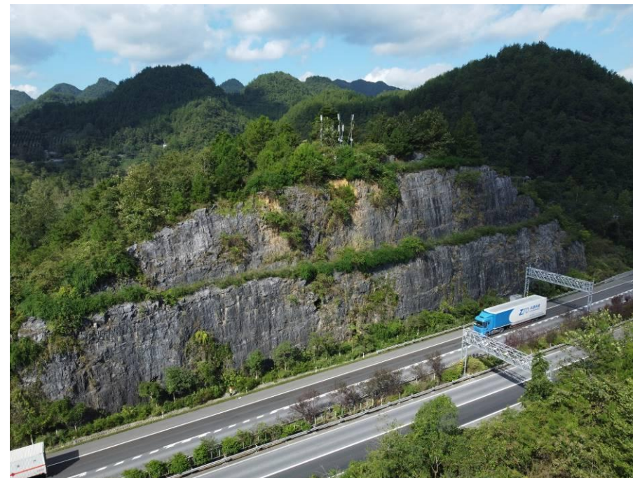
图 1.2 边坡正面全景照片
