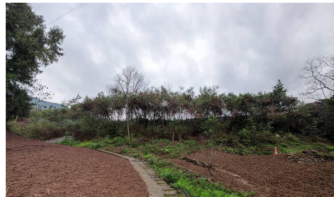
图 1.7 路基下方全景照 (仰视)
