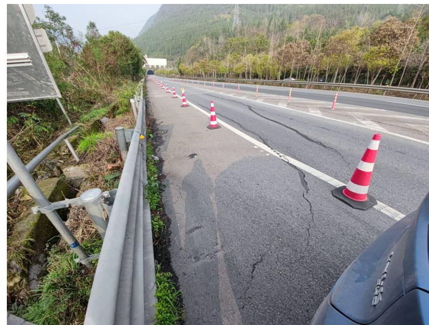
图 1.4 路面开裂情况 1 (DL2、DL3)
