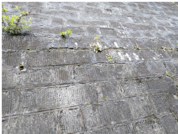
图 2 护面墙开裂
