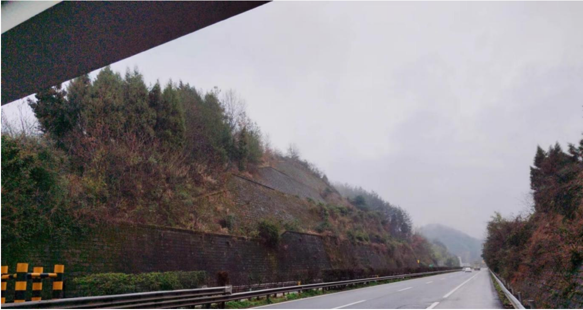
图 12 K1541+000（进城方向·右幅）护面墙现场照
