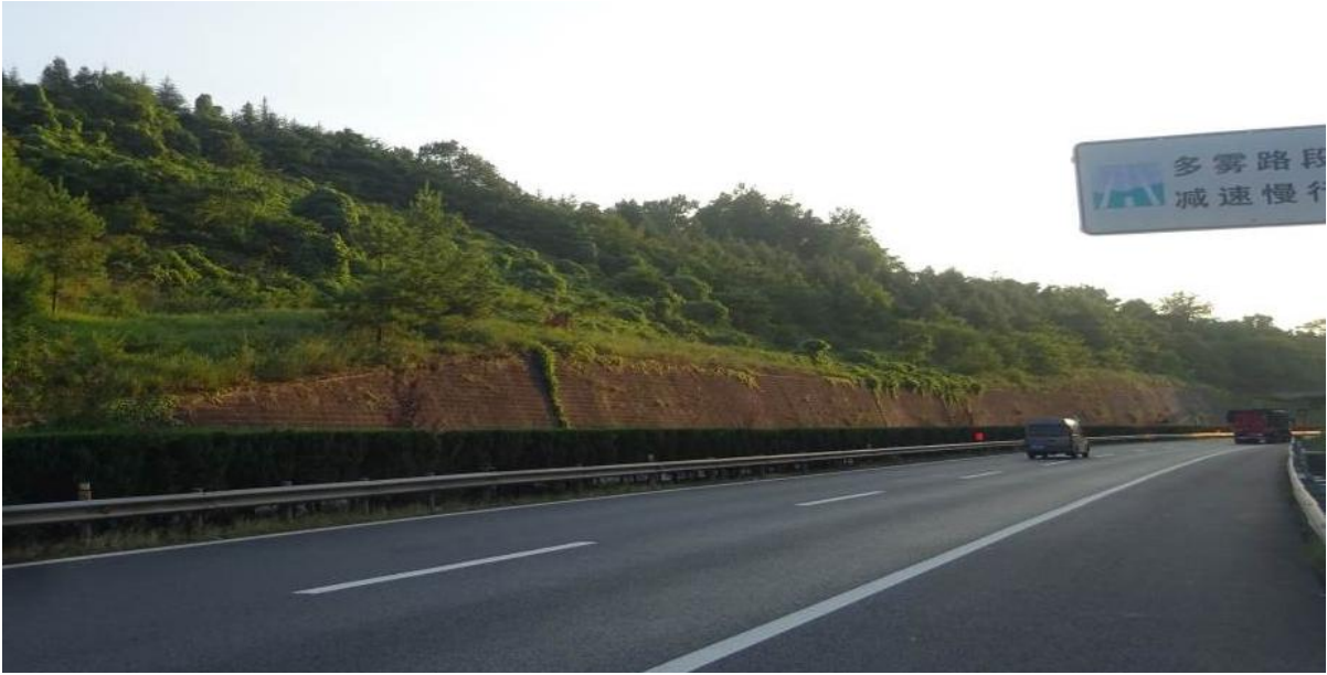
图 10 K1532+300（出城方向·左幅）护面墙现场照
