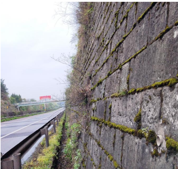
图 7 护面墙轻微外倾
