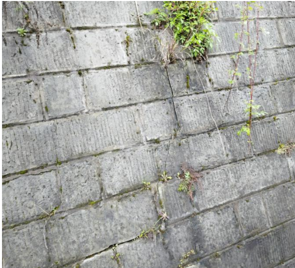
图 6 护面墙开裂
