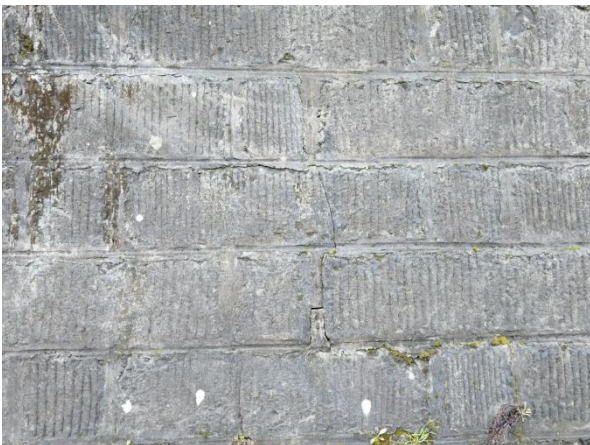
图 3 护面墙开裂
