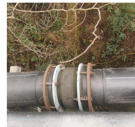
图 1.1-6 沙坝水库大桥伸缩接头现状
