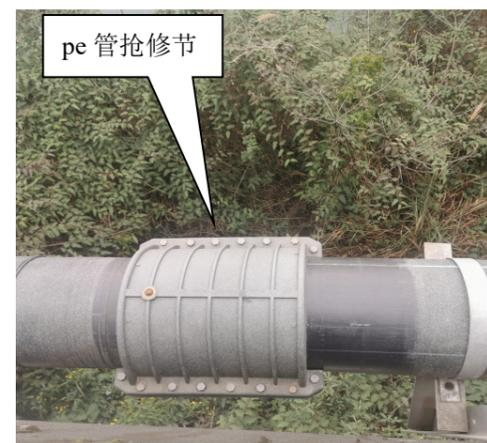
图 1.1-5 沙坝水库大桥排水管伸缩异常
