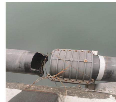
图 1.1-4 沙坝水库大桥排水管脱节
