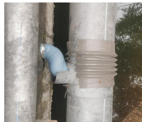
图 1.1-3 沙坝水库大桥径流系统排水管错位
