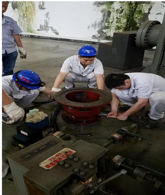
图 3：调速器油泵更换
