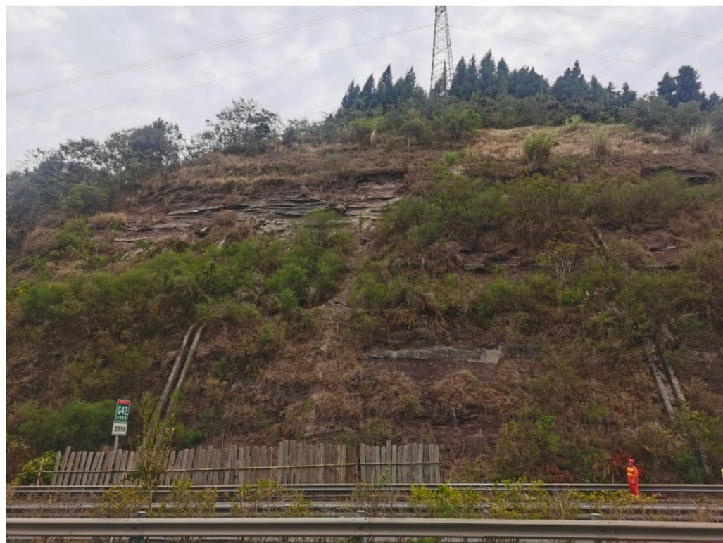
图 1 边坡正面垮塌照片
