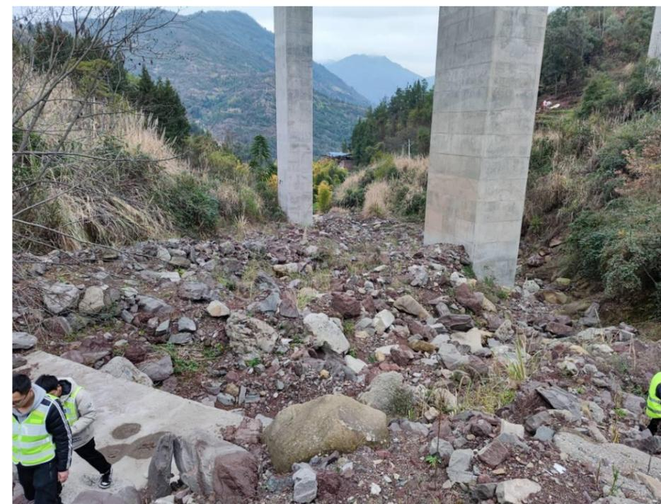
图 3 桥墩附近淤积、堵塞以及排洪渠被掩埋情况
