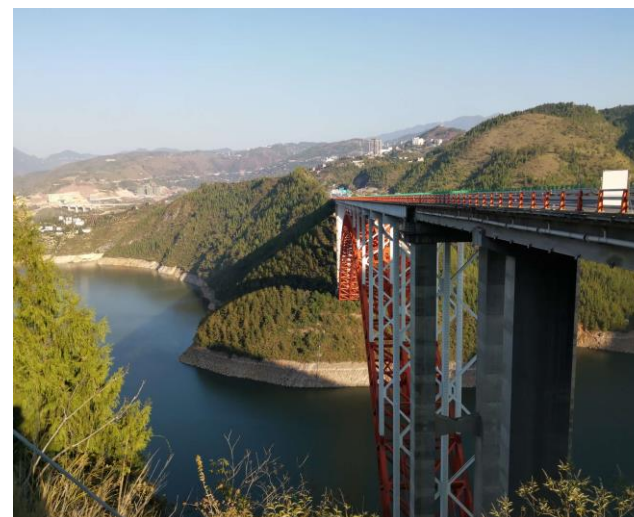
图 1.2.3-1 大宁河特大桥立面照
