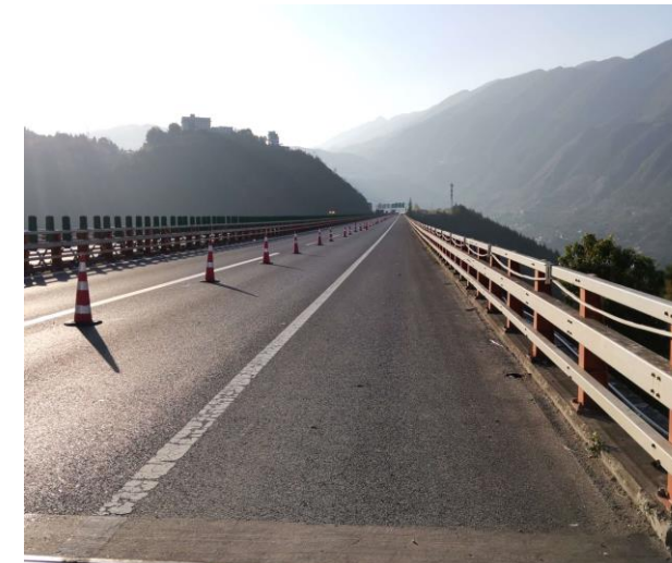
图 1.2.3-2 大宁河特大桥桥面照
