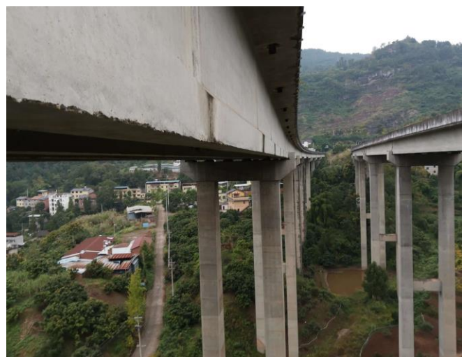
图 1.2.4-1 龚家湾大桥立面照
