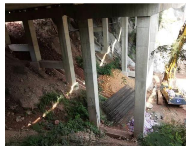
图 5.1-1 桥下右侧施工现场
