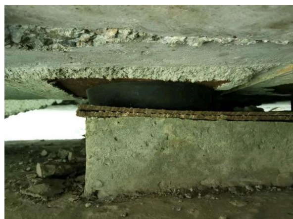
图 3.5-3 L1-1-2# 支座左侧横向剪切
