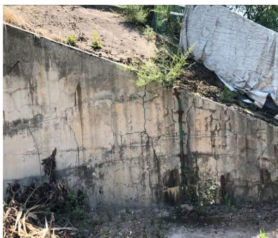
图 3.19-1 八字墙开裂
