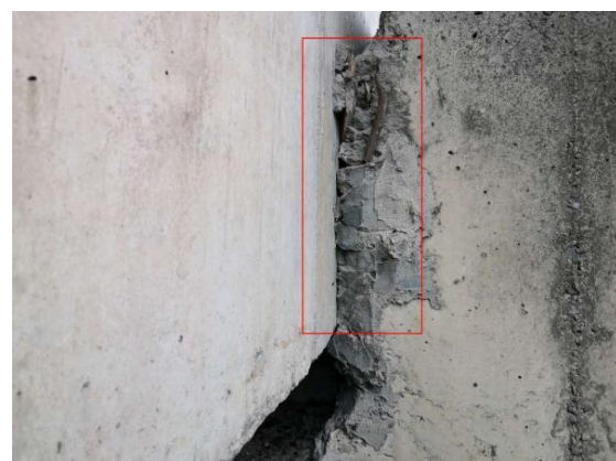
图 3.4-8 R2#盖梁挡块抵死
