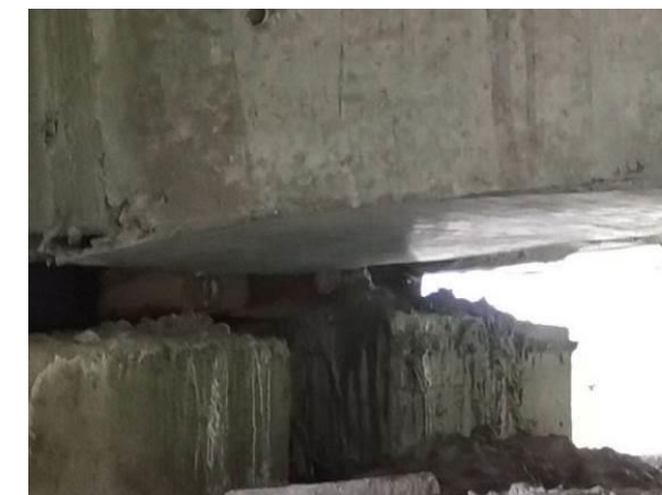
图 3.2-6 L-6-6-5#支座左侧剪切变形
