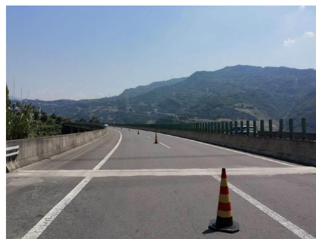
图 1.2.2-2 三里河大桥桥面照
