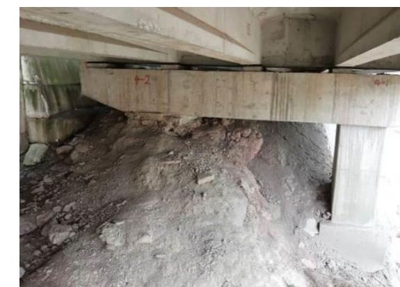
图 3.1-10 R-4#桥墩桩基基础现状
