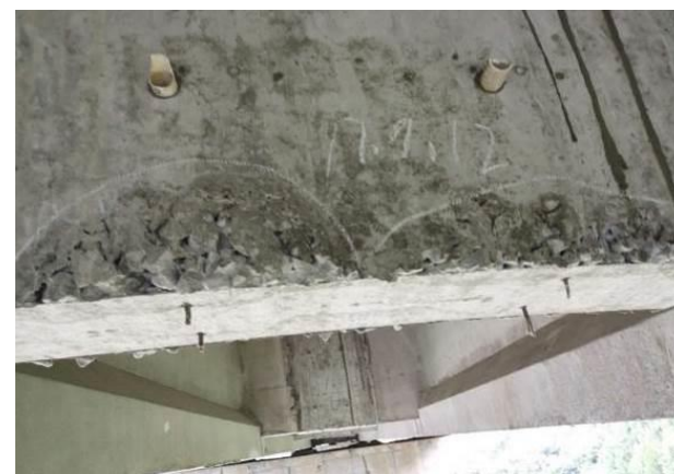
图 3.2-4 L10-2-4#横隔板底面蜂窝、麻面
