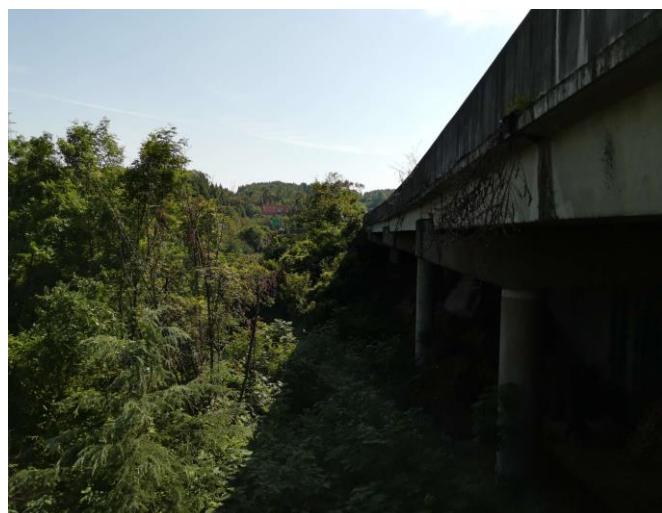
图 1.2.5-1 万家坝大桥立面照
