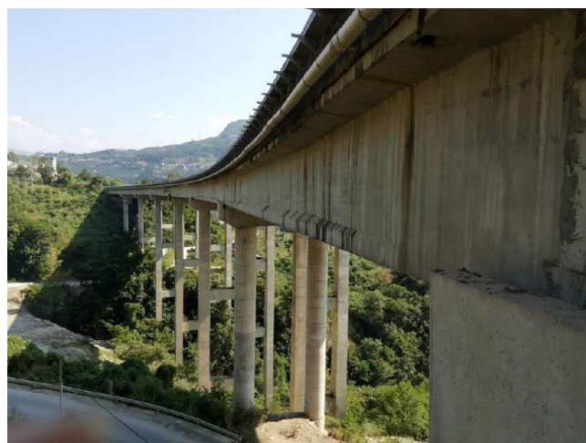
图 1.2.2-1 三里河大桥立面照
