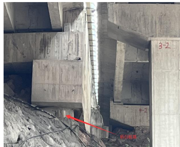
图 4.1-7 大丘坎中桥桥台现场图
