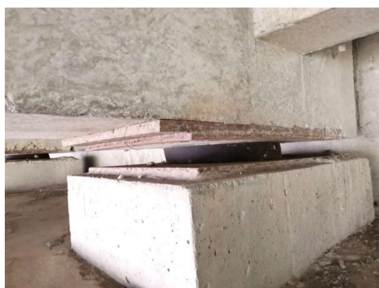
图 3.3-5 L1-0-3#支座大桩号面纵向剪切
