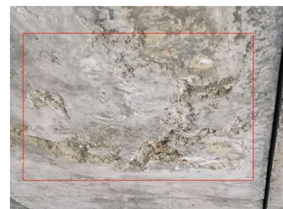
图 3.5-1 L3-4#空心板板底蜂窝、麻面
