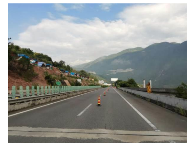
图 5.1-2 桥梁左侧抗滑桩施工
