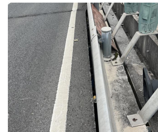
图 4.1-2 护栏底座与路面间隙
