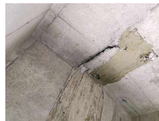
图 3.3-3 L4-3#湿接缝底面剥落
