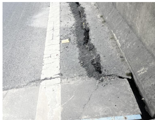
图 5.2-2 桥台处纵缝
