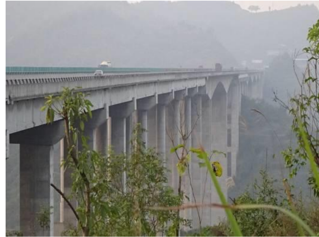
朝阳寺特大桥立面照
