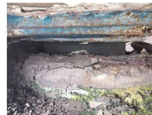
图2.2-78 左幅9-9-5#支座老化变质
