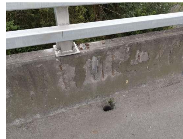
图 2.2-28 渝邻 2 号桥左幅 1#防撞挡墙
