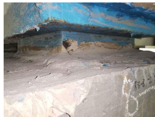
图2.2-80 右幅8-8-2#支座老化变质
