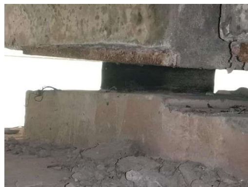
图2.2.2-32 右幅6-5-7#支座老化变质
