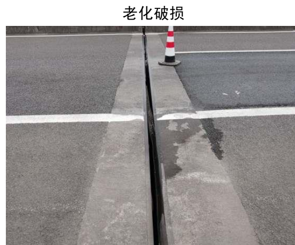
图 2.2-23 楠花 2#桥左幅 2#伸缩缝橡胶止水带
