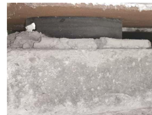
图2.2-86 左幅4-3-5#支座老化变质
