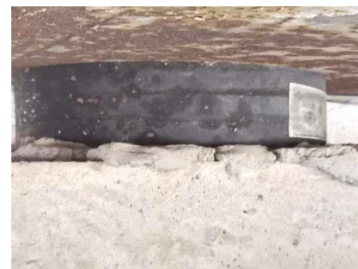
图2.2-61 右幅2-1-8#支座老化变质
