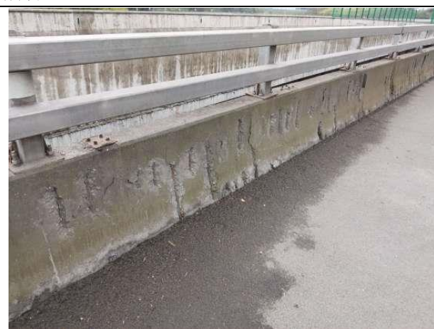
图 2.2-26 古路大桥左幅 1#防撞挡墙
