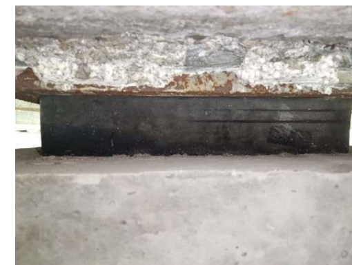
图2.2-92 右幅3-3-3#支座老化变质
