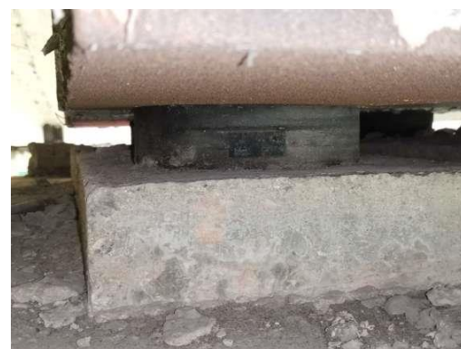
图2.2.2-42 左幅2-1-9#支座老化变质
