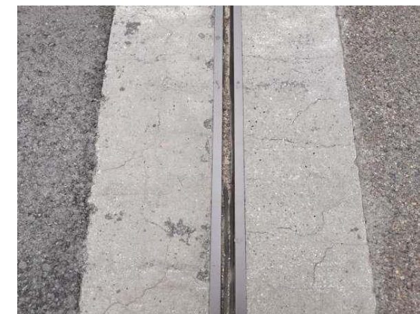
图 2.2-24 温塘河大桥右幅 2#伸缩缝
