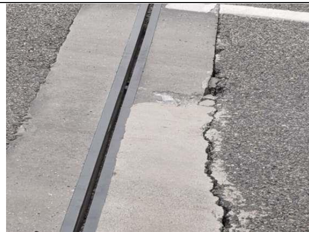
图 2.2-20 草坪立交桥右幅 2#伸缩缝
