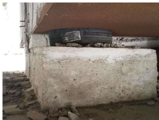
图2.2-95 右幅1-1-5#支座老化变质
