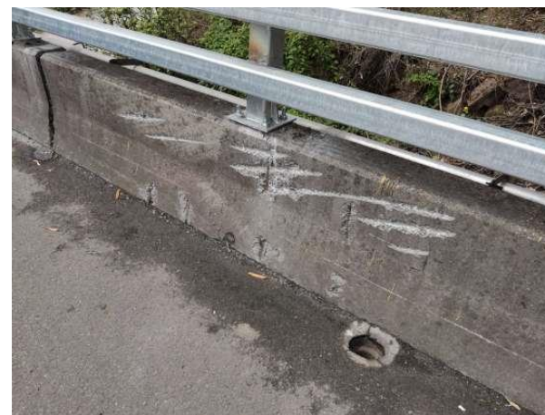
图 2.2-27 石夹口大桥右幅 1#防撞挡墙
