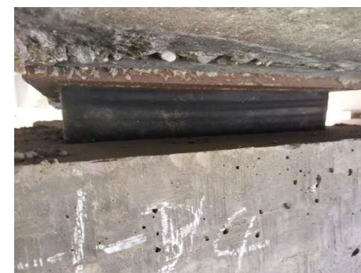
图2.2-54 右幅1-1-4#支座老化变质
