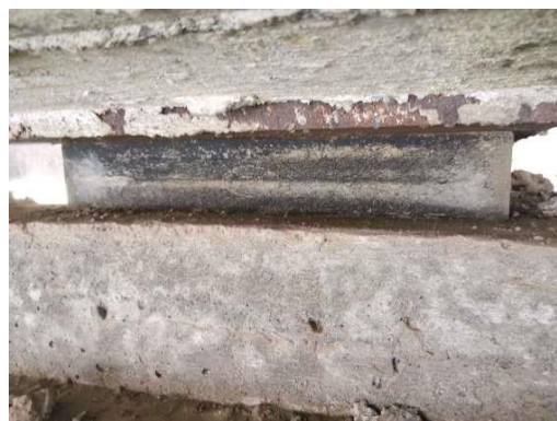
图2.2-39 右幅3-2-3#支座老化变质
