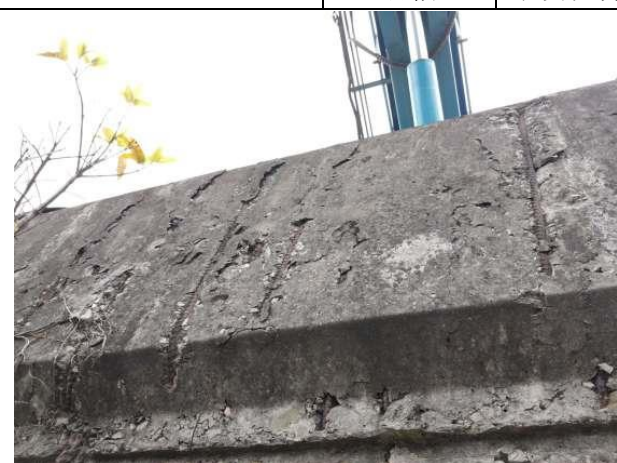
图 2.2-25 柏树湾大桥左幅 1#防撞挡墙
