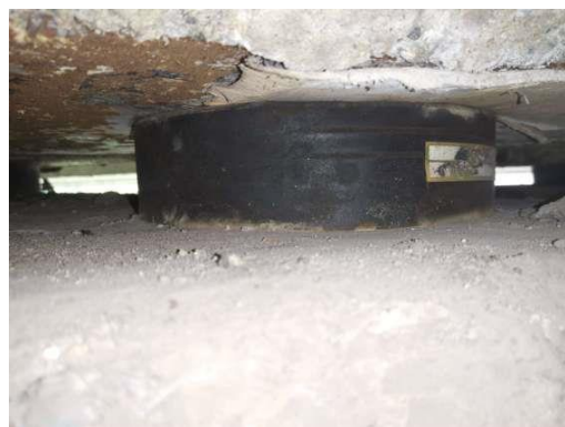
图2.2-73 右幅1-1-10#支座老化变质
