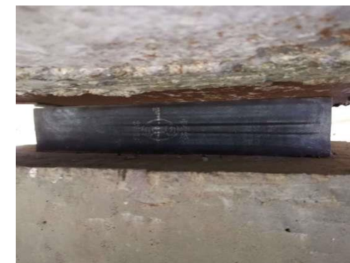
图2.2-60 右幅2-2-2#支座老化变质
