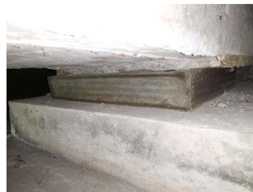
图2.2.2-35 右幅8-8-4#支座串动
