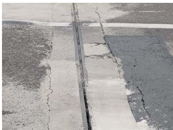
图 2.2-19 草坪立交桥右幅 1#伸缩缝
