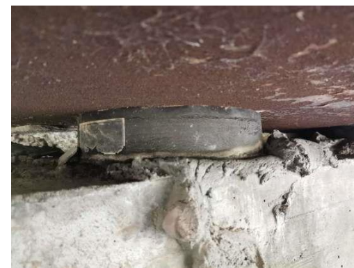
图2.2-67 右幅4-4-15#支座老化变质
