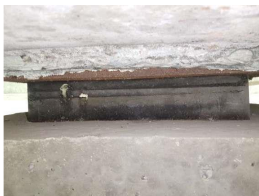
图2.2-89 左幅5-4-3#支座老化变质
