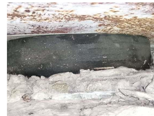
图2.2-68 右幅2-2-11#支座老化变质
