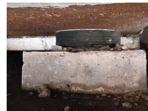
图2.2-94 右幅1-0-7#支座老化变质
